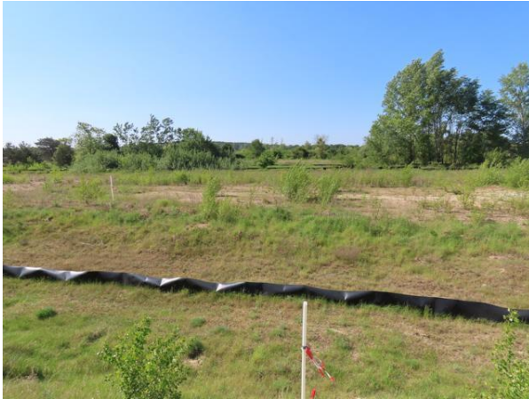
Abb. 14: Schutzzaun für den Abriss von Fahrzeughallen
