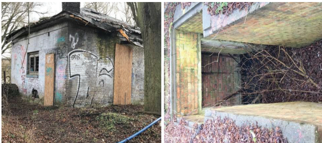
Abb. 11: Ehemaliges Pumpenhaus und Brunnenbauwerk nordöstlich des Fähnrichheims (Nr. 6)
