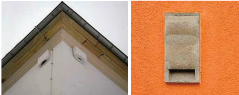
Abb. 14: Außen an die Fassade angebrachte Ersatzquartiere (links) sowie integrierter Quartierstein (aus Schmidt 2014)
