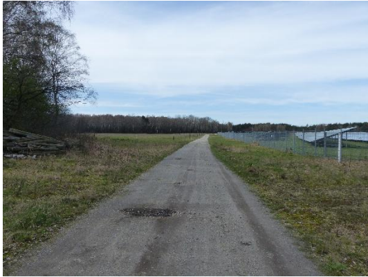
Foto 7: Wander-/ Radweg und Photovoltaik-Freiflächenanlage im Plangebiet
