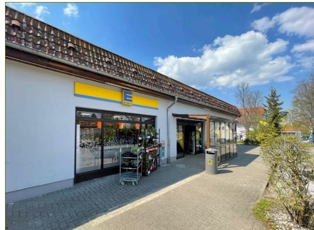
Abbildung 39: OTZ Senzig: LM-Vollsortimenter Chausseestraße Quelle: Consilium GmbH
