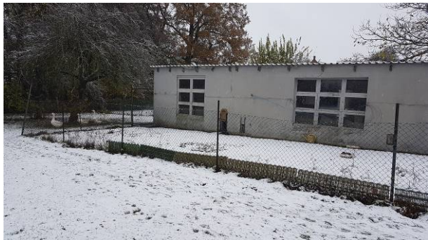
Gebäude zur Geflügelhaltung, gemauert und verputzt, Flachdach; ohne geeignete Habitatbedingungen für Fledermäuse / Brutvögel
