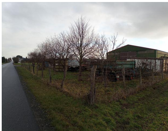
Abb. 27: Planfläche Blick von Ecke SW auf Halle (01.12.25)
