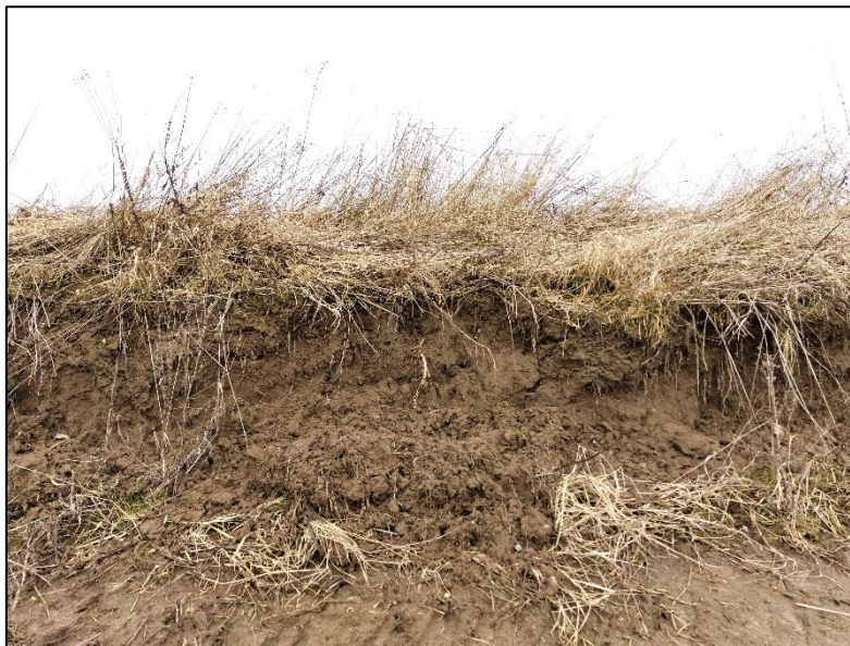
Abbildung 6 Geländekante entlang des südlich angrenzenden Bestandsweges
