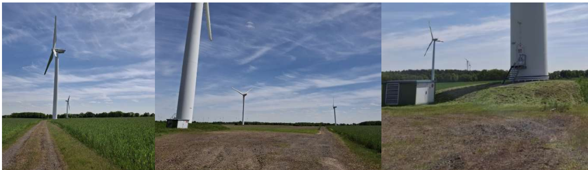
Abbildung 17: Zufahrt (teilversiegelte Wege; linkes Bild), Kranstellfläche, Turm, Fundament und Trafo verschiedener Bestandsanlagen (WEA; mittleres und rechtes Bild).
