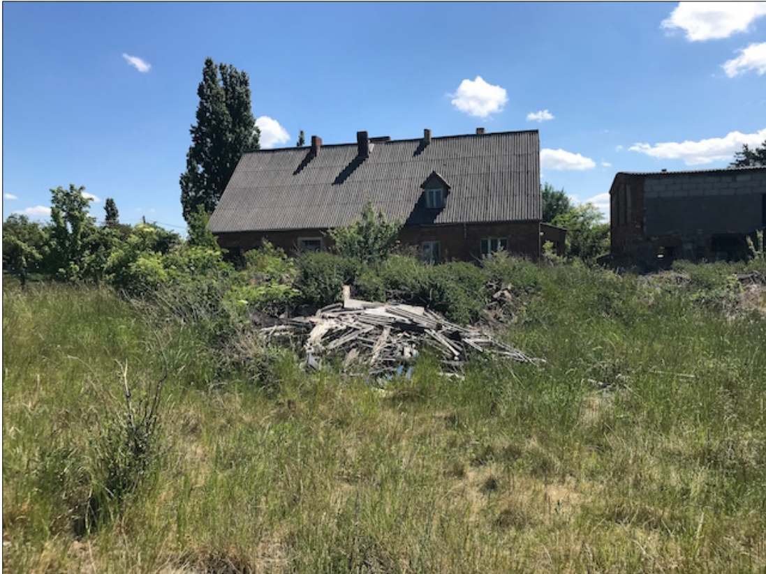
Foto 1: ehemalige Hoffläche mit Ablagerungen und unterschiedlichen Sukzessionsstadien, Wohnhaus im Hintergrund (03.06.2022)
