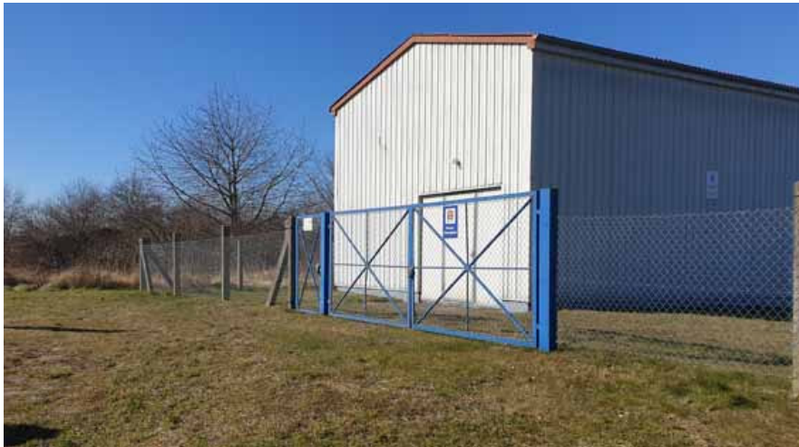
Pumpwerk im nördlichen Bereich des Gutsgeländes 2022 – Flurstück 28
