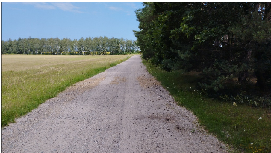
teibefestigter Weg im Osten des UR (von Sorge in Richtung Walddrehna)
