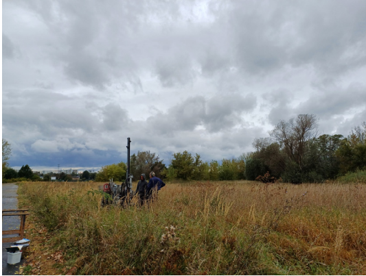
Bohrposition der RKS 10/24 entlang der Zufahrt zum Gewächshaus; Blick nach Westen.
