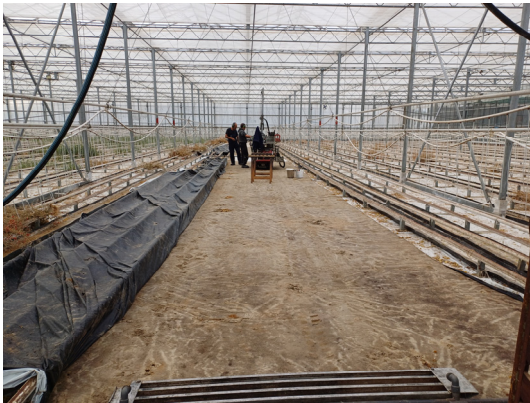
Bohrarbeiten an der RKS 2/24 im südwestlichen Hallenbereich.
