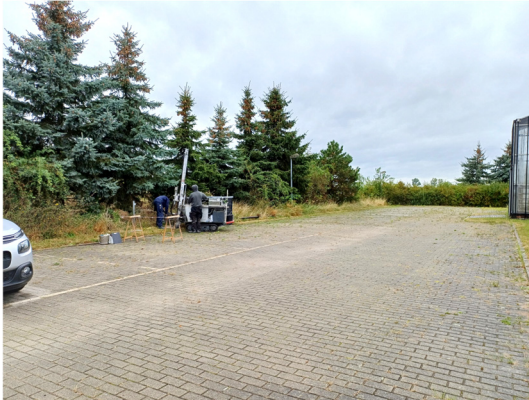
Bohrposition der RKS 8/24 westlich des Gewächshauses; Blick nach Norden.
