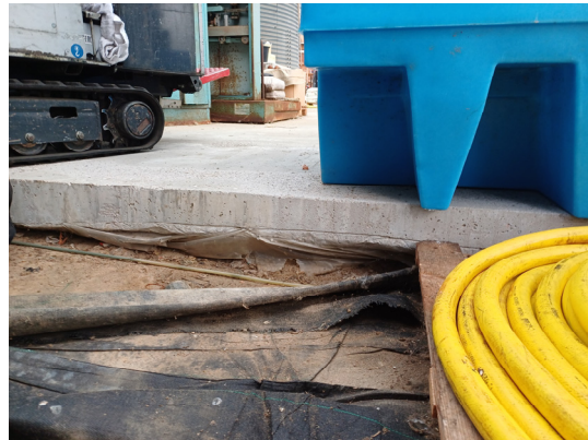
Detailansicht der Bodenplatte, ca. 21 cm mächtig, von einer Plastikfolie unterlagert.
