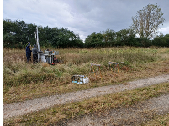
Südwestlicher Grundstücksbereich, hier: Bohrposition RKS 11/24; Blick nach Südwesten.
