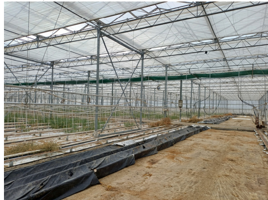
Bohrposition der RKS 3/24 im nordwestlichen Hallenbereich.
