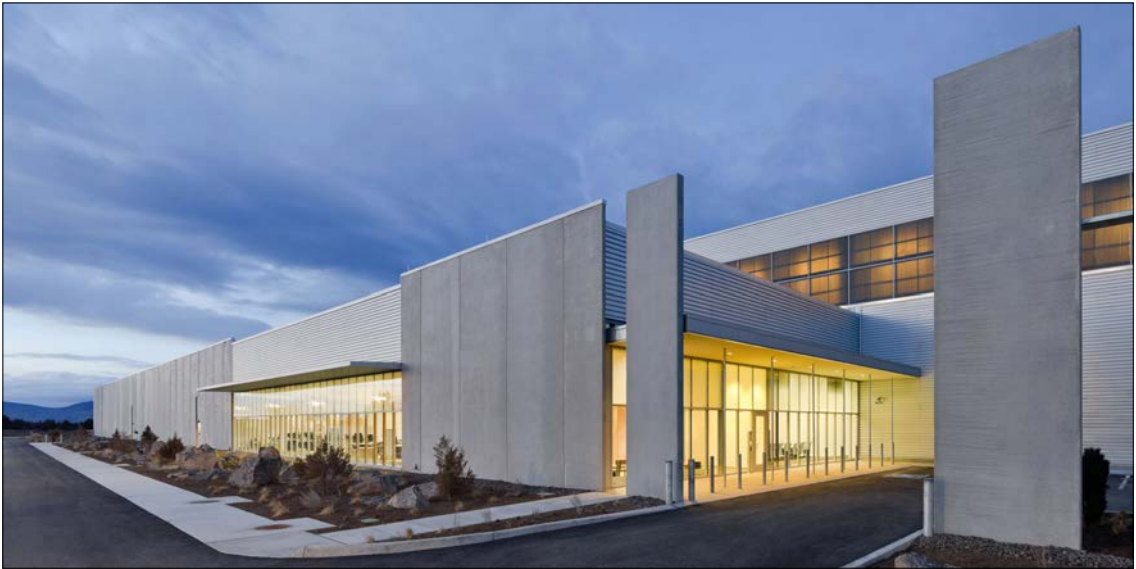
Abb. 11: Beispiel für ein Rechenzentrum (Quelle: Minstrel Consulting GmbH)
