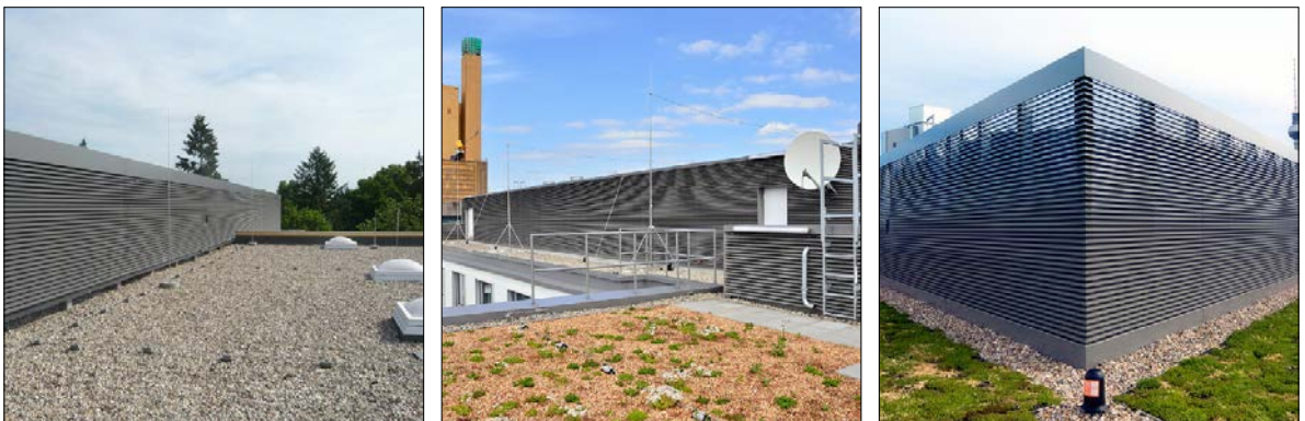
Abb. 37: Technikeinhausungen (Quelle: https://www.wetterschutzgitter.com/lamellenwaende/technikaufbauten )
