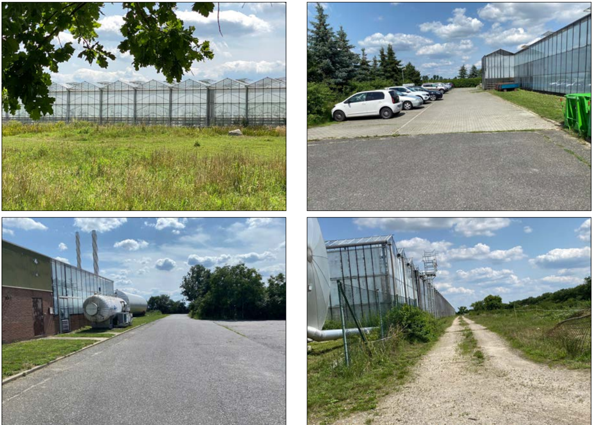
Abb. 5: Gewächshaus am Mehrower Weg (Bestandsaufnahme 07/2021)
