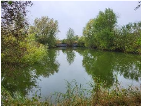
Abb. 45: Regenrückhaltebecken mit Baumbe- ständen
