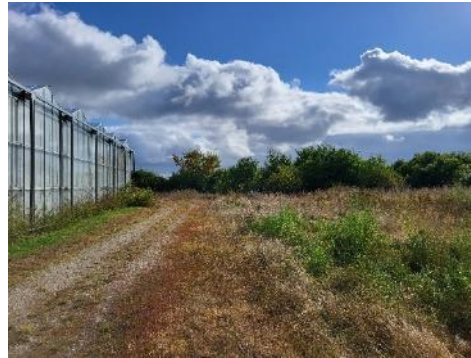
Abb. 56: Geschotterter Weg am Ende des Gewächshauses im Süden
