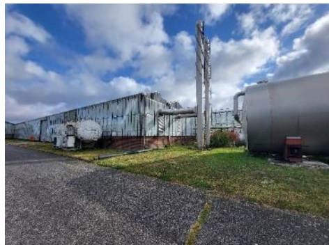
Abb. 44: Gewächshaus mit vorgelagerten Tanks
