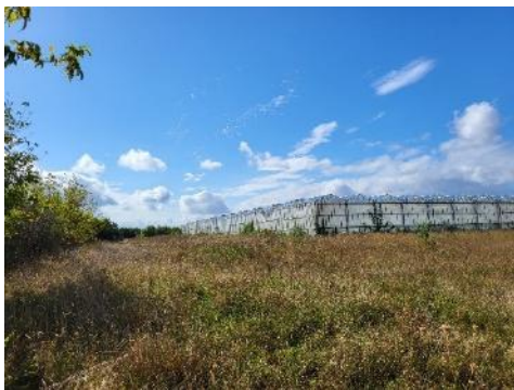
Abb. 25: Blickrichtung Gewächshaus von Nord- osten
