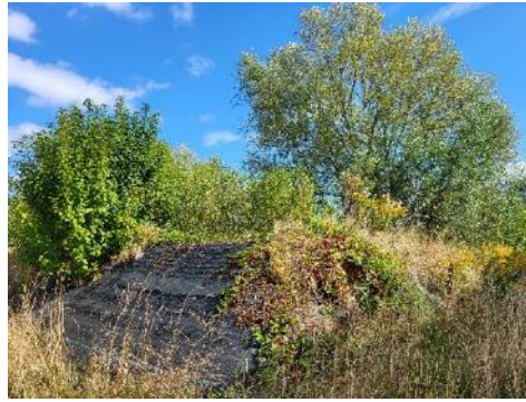
Abb. 46: Regenrückhaltebecken mit Vegetati- onsbestand
