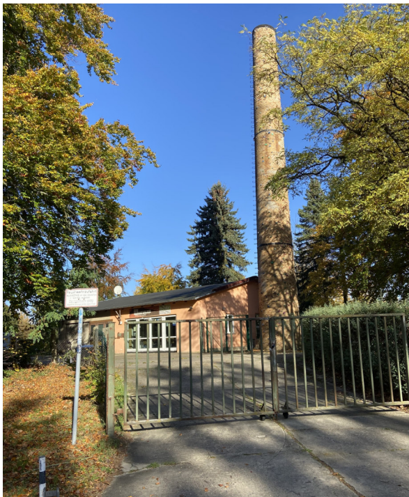
Abbildung 4: Altes Heizwerk (Blick von Süden)
