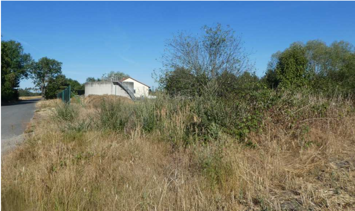
Foto 6. Die Kläranlage Münchhausen ist von dichtem Strauchwerk umgeben.- Foto: R. Möckel (07.08.2022)
