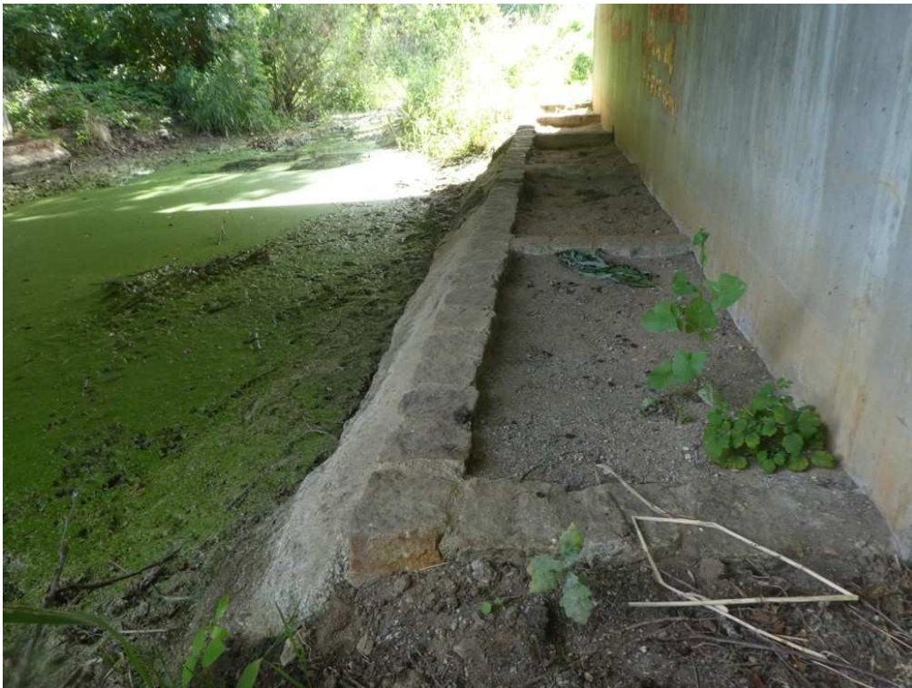
Foto 25. Uferbankette an der Kleinen Elster unter der Brücke der B96, sie verhindert wirksam Verkehrsverluste beim Fischotter.- Foto: R. Möckel (17.07.2022)
