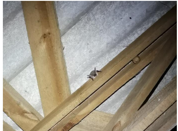
Abb. 23 Lagerhalle an der westlichen Grenze des Plangebiets mit Erfassung des Grauen Langohrs in den Dachbalken am 24.08.23
