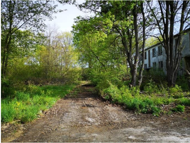
Abb. 7 Blickrichtung N; Sukzessionsaufwuchs auf teilversiegelten Flächen im nördlichen Teil des Plangebiets auf das Bürogebäude
