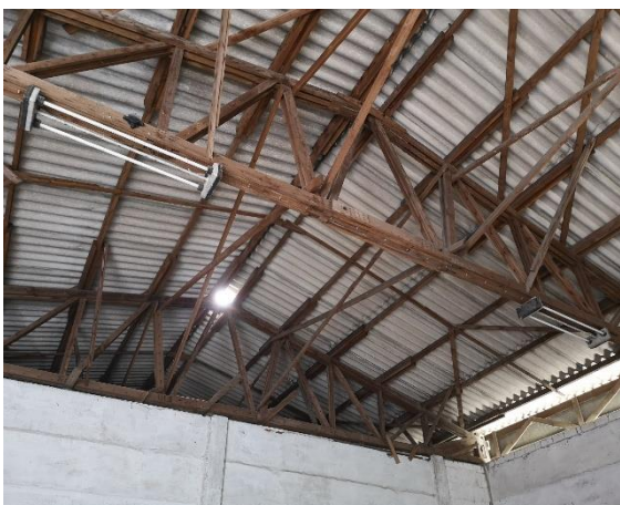
Abb. 27; Lagerhalle an der südlichen Grenze des Plangebiets mit Habitatpotenzial für Fledermäuse und Gebäudebrüter
