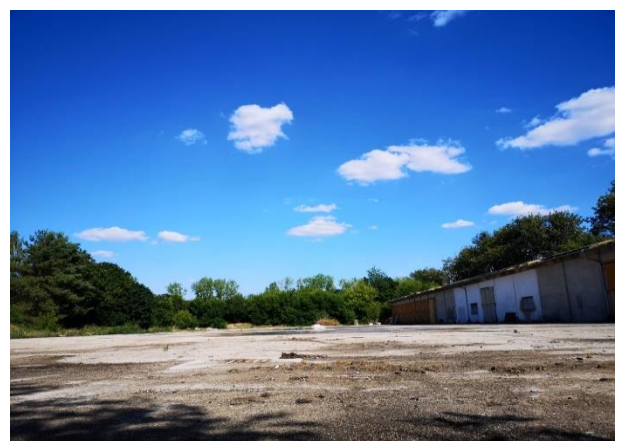
Abb. 18, Blickrichtung O; Versiegelte Flächen und Lagerhallen an der südlichen Grenze des Plangebiets
