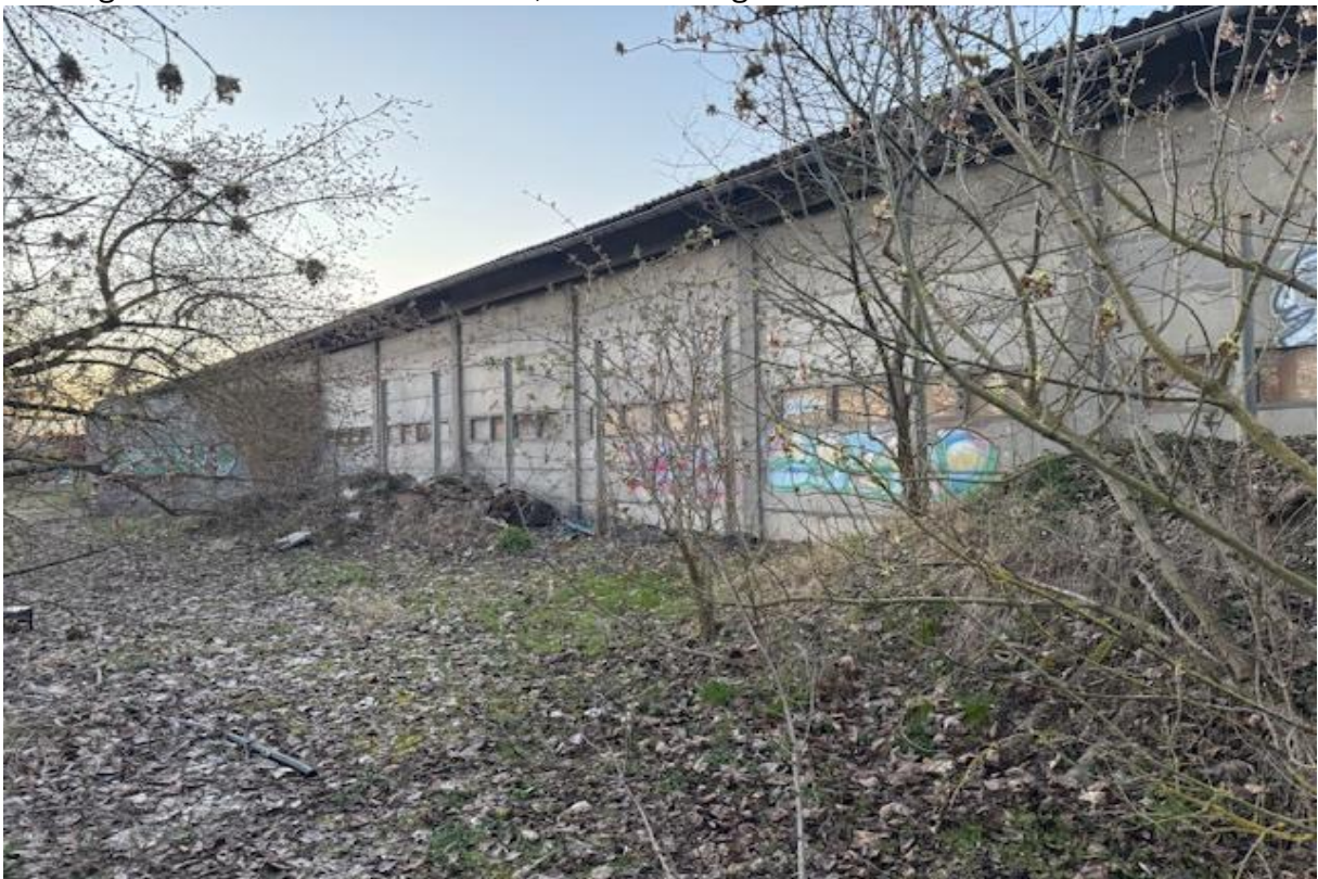
Versiegelte Fläche südlich Halle H2; Blickrichtung Westen
