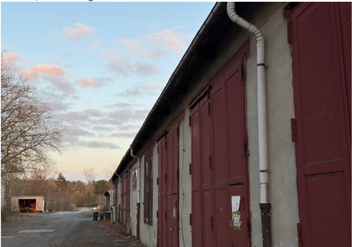
Halle H5; Blickrichtung Osten
