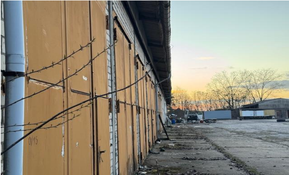
nördliche versiegelte Fläche an Halle H2; Blickrichtung Westen
