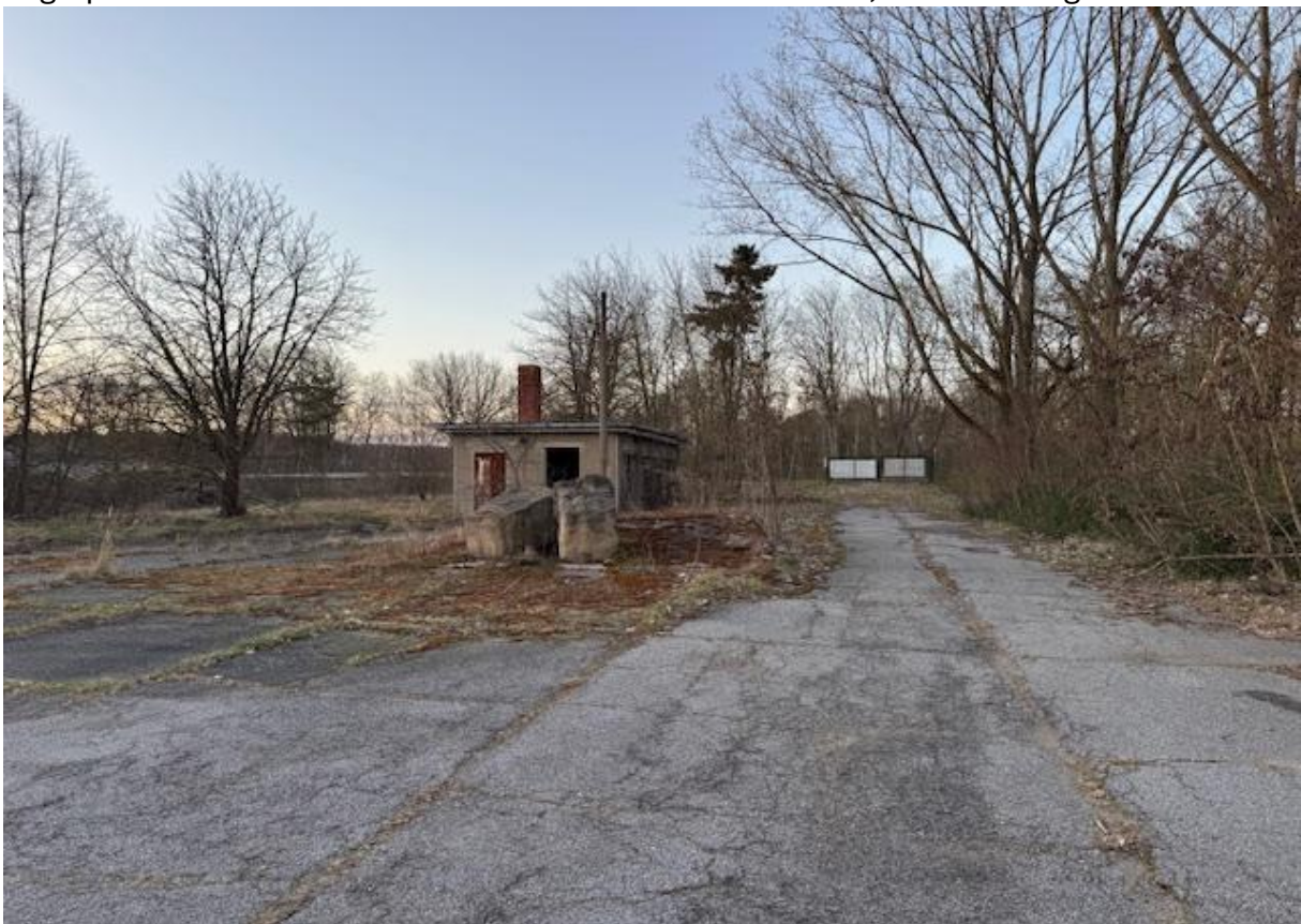
Gebäude PF und Einfahrt Nordost; Blickrichtung Norden
