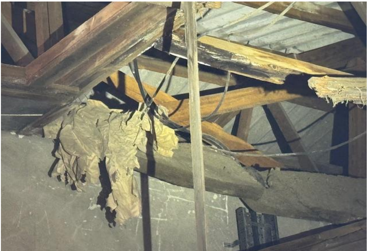
Halle H5; Innenansicht
