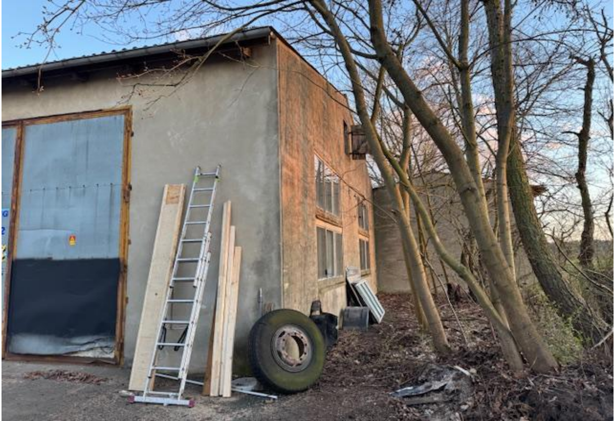
Halle H5 links, dahinter Halle H4, westliche Grundstücksgrenze; Blickrichtung Süden
