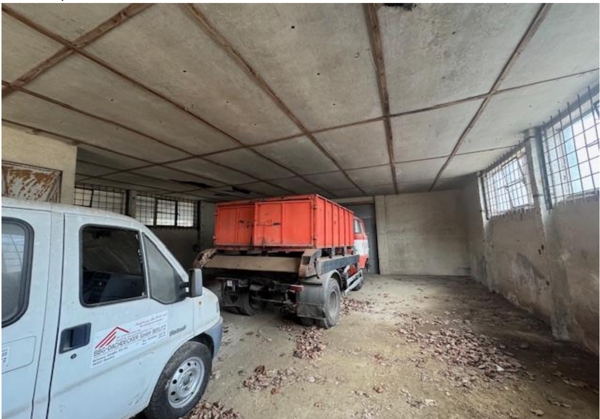
Halle H5; Innenansicht
