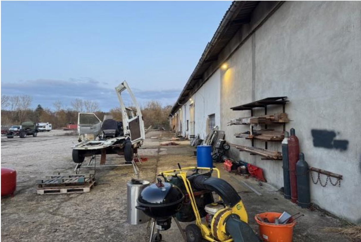
nördliche versiegelte Fläche an Halle H2; Blickrichtung Osten
