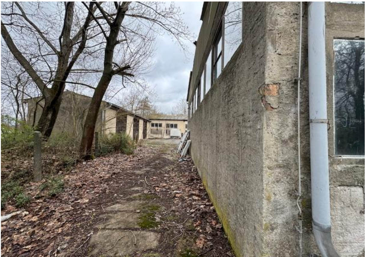
Halle H4 links; Halle H3 rechts; Blickrichtung Norden
