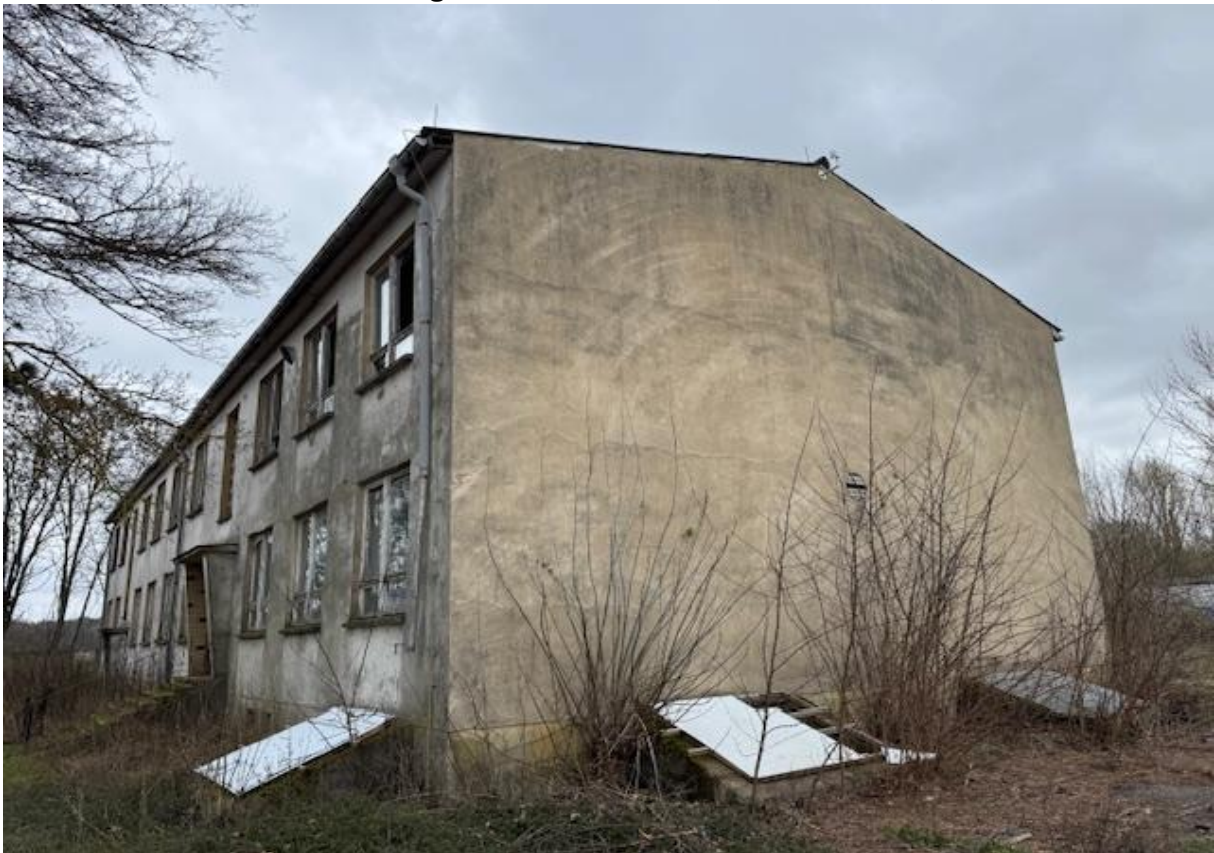
Gebäude VW; Blickrichtung Norden
