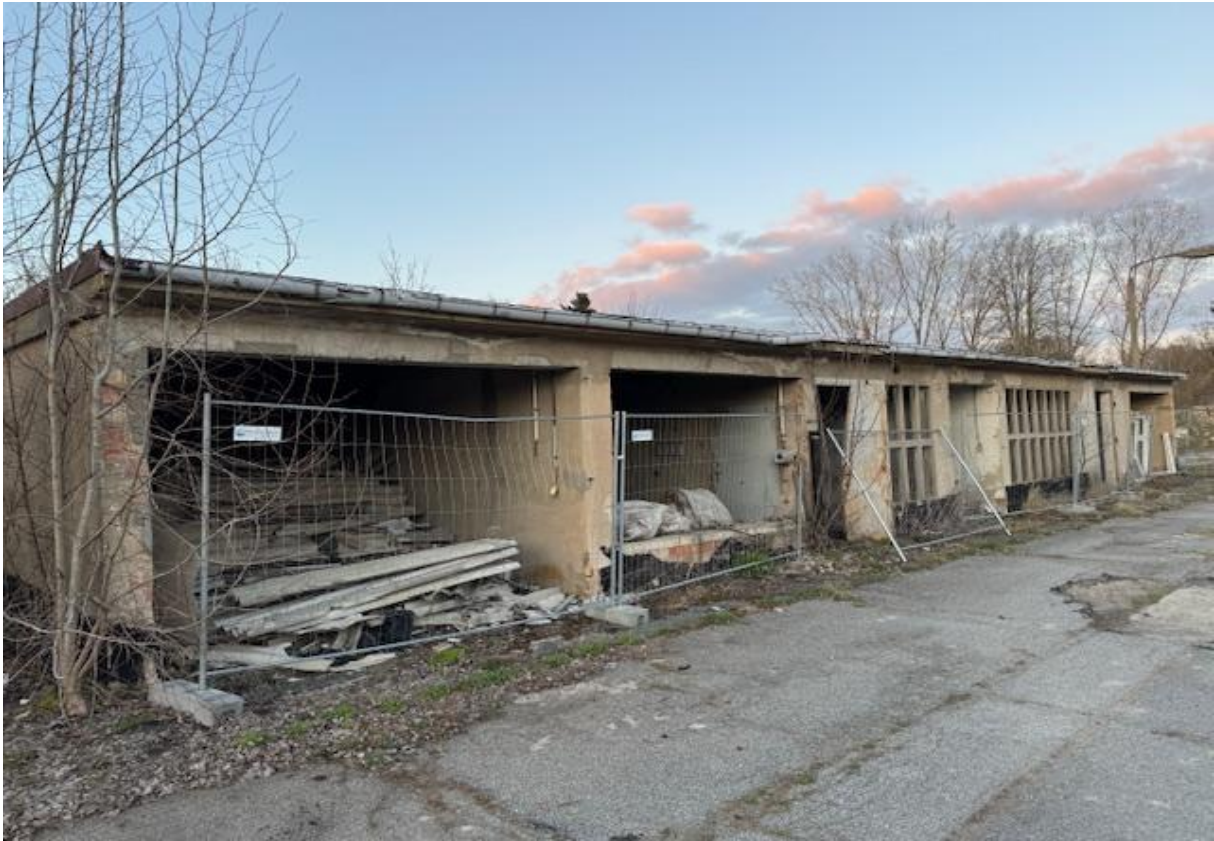
Halle H8; Blickrichtung Osten
