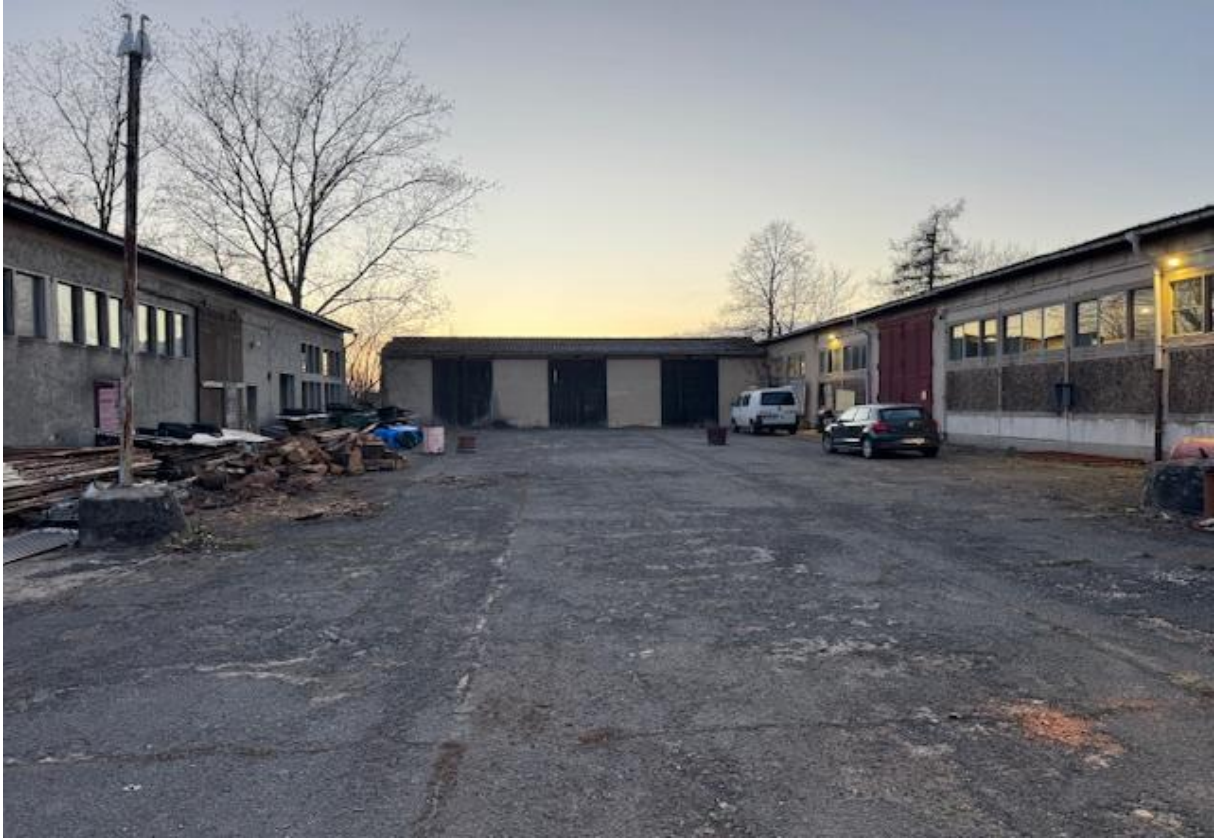
Halle H5 rechts, Halle H4 mittig, Halle H3 links; Blickrichtung Westen
