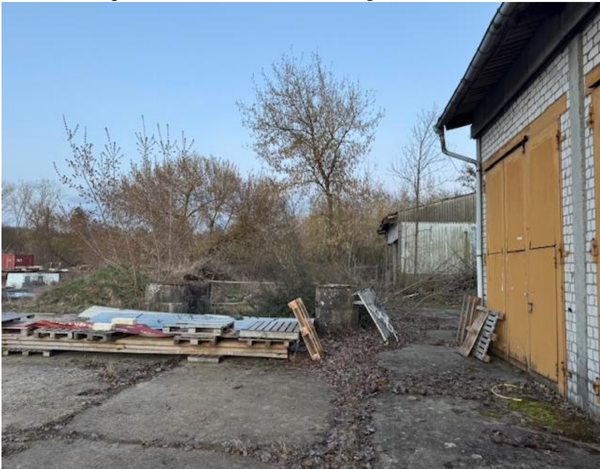
nördliche versiegelte Fläche an Halle H2; Blickrichtung Osten, im Hintergrund Halle H1
