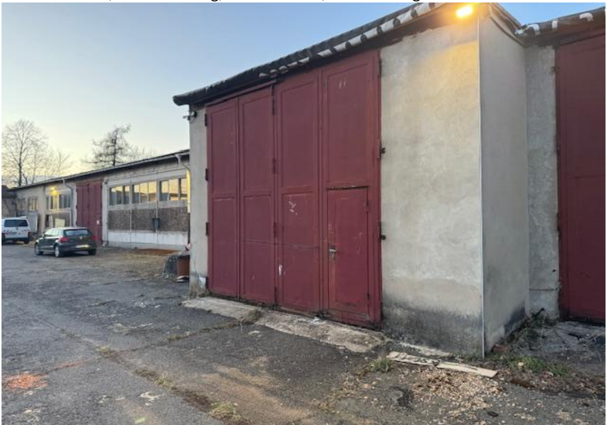
Halle H5; Blickrichtung Westen
