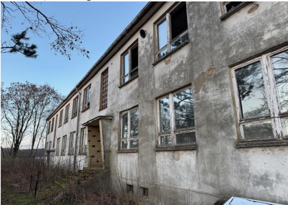
Gebäude VW; Blickrichtung Norden
