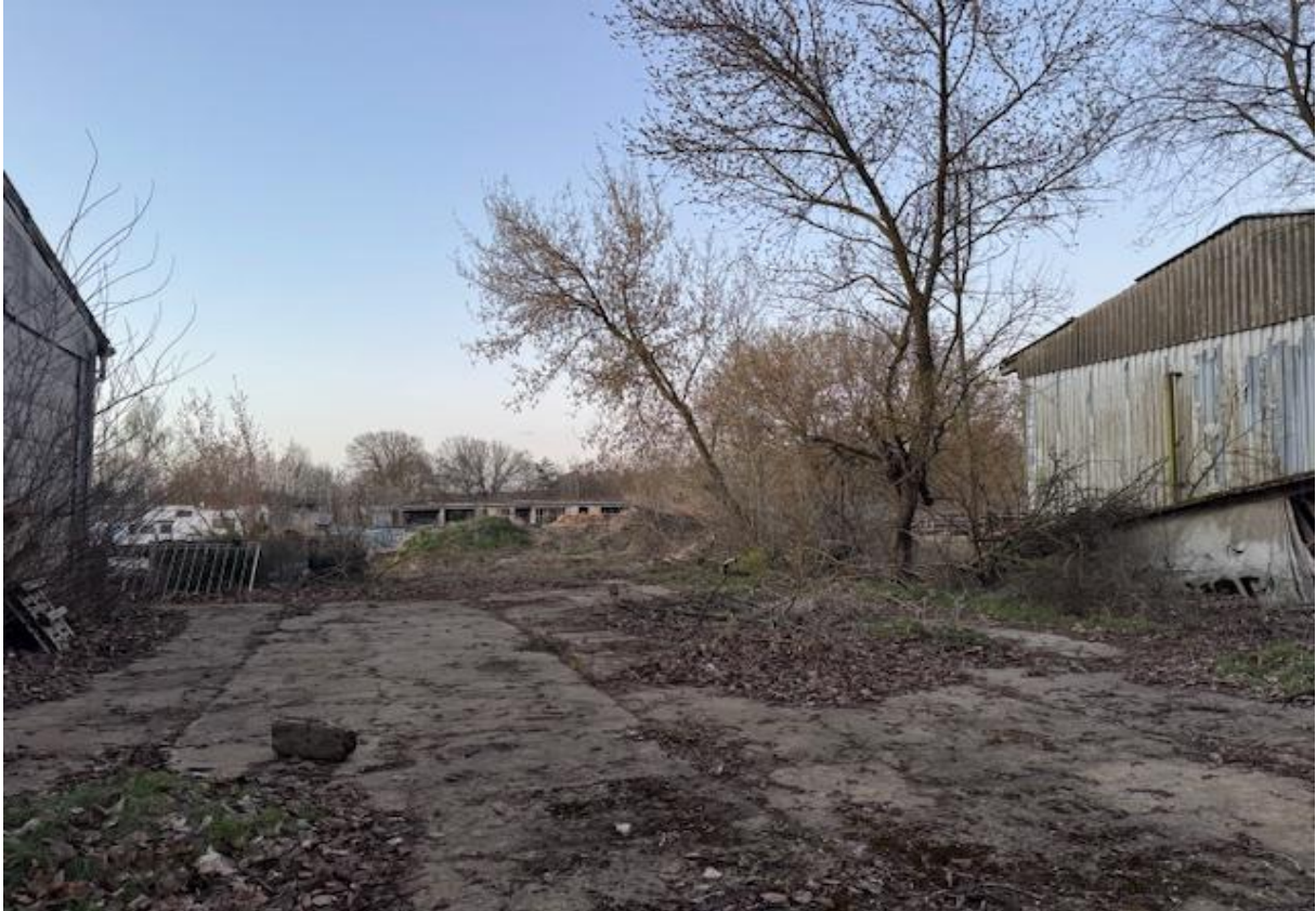
Versiegelte Fläche zwischen Halle H2 (links) und Halle H1 (rechts); Blickrichtung Norden
