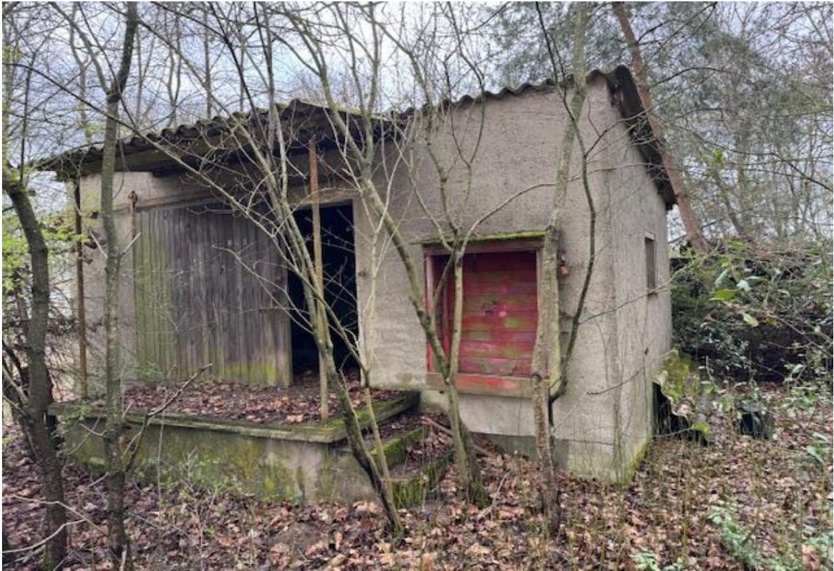
Gebäude BN; Blickrichtung Süden
