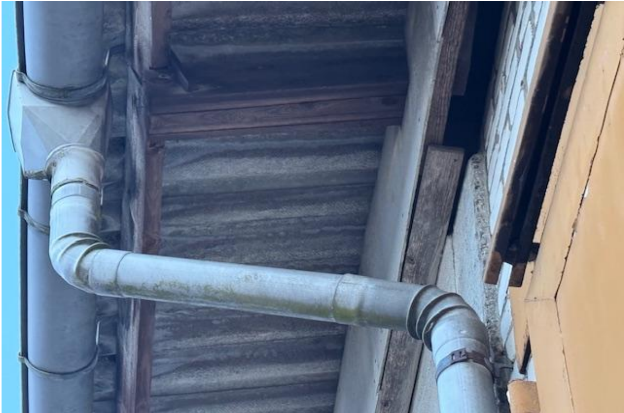
Halle H2; Quartier- und Niststruktur, Fortpflanzungs- und Ruhestätte (potenziell Einflugbereich)
