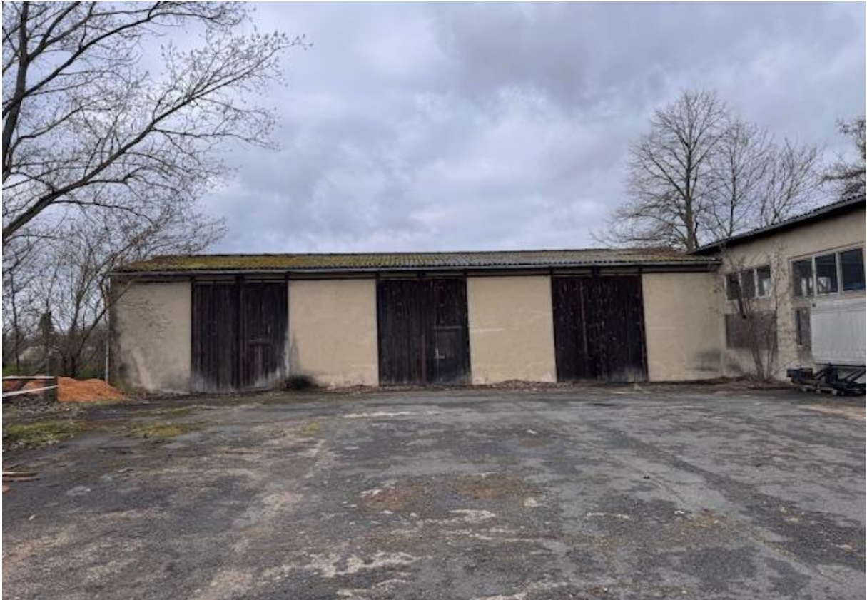
Halle H4; Blickrichtung Westen
