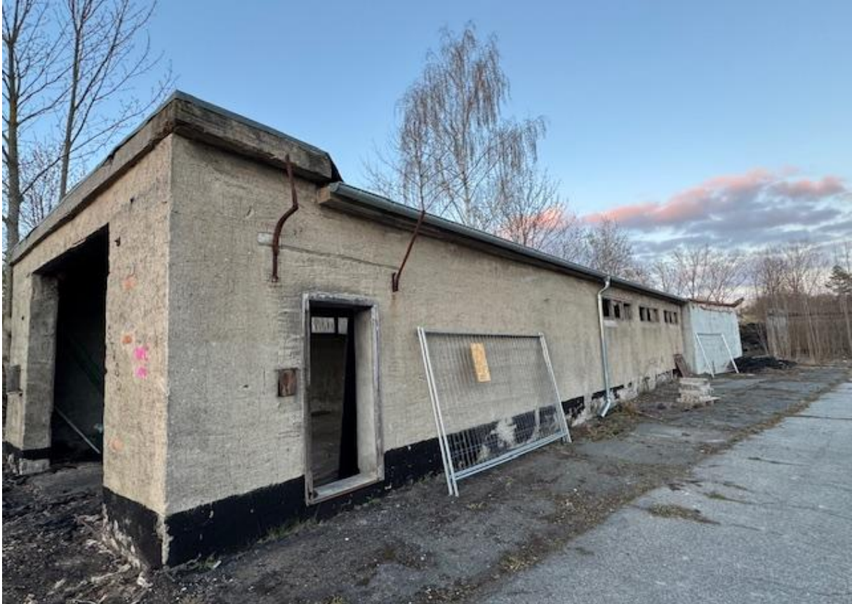
Halle H7; Blickrichtung Osten
