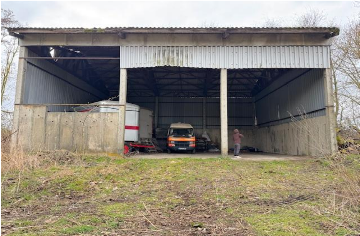
Halle H 1 Vorderansicht; Blickrichtung Süden
