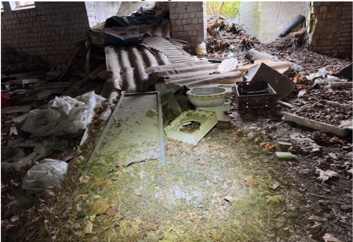
Innenansicht Gebäude VW, Keller
