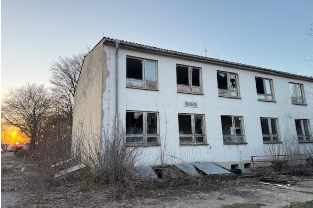
Gebäude VW; Blickrichtung Westen
