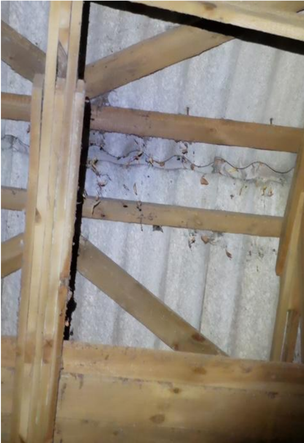
Halle 4, Innenansicht, Dachstuhl
