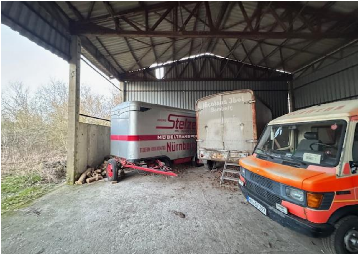
Halle H 1 Innenansicht; Blickrichtung Osten
