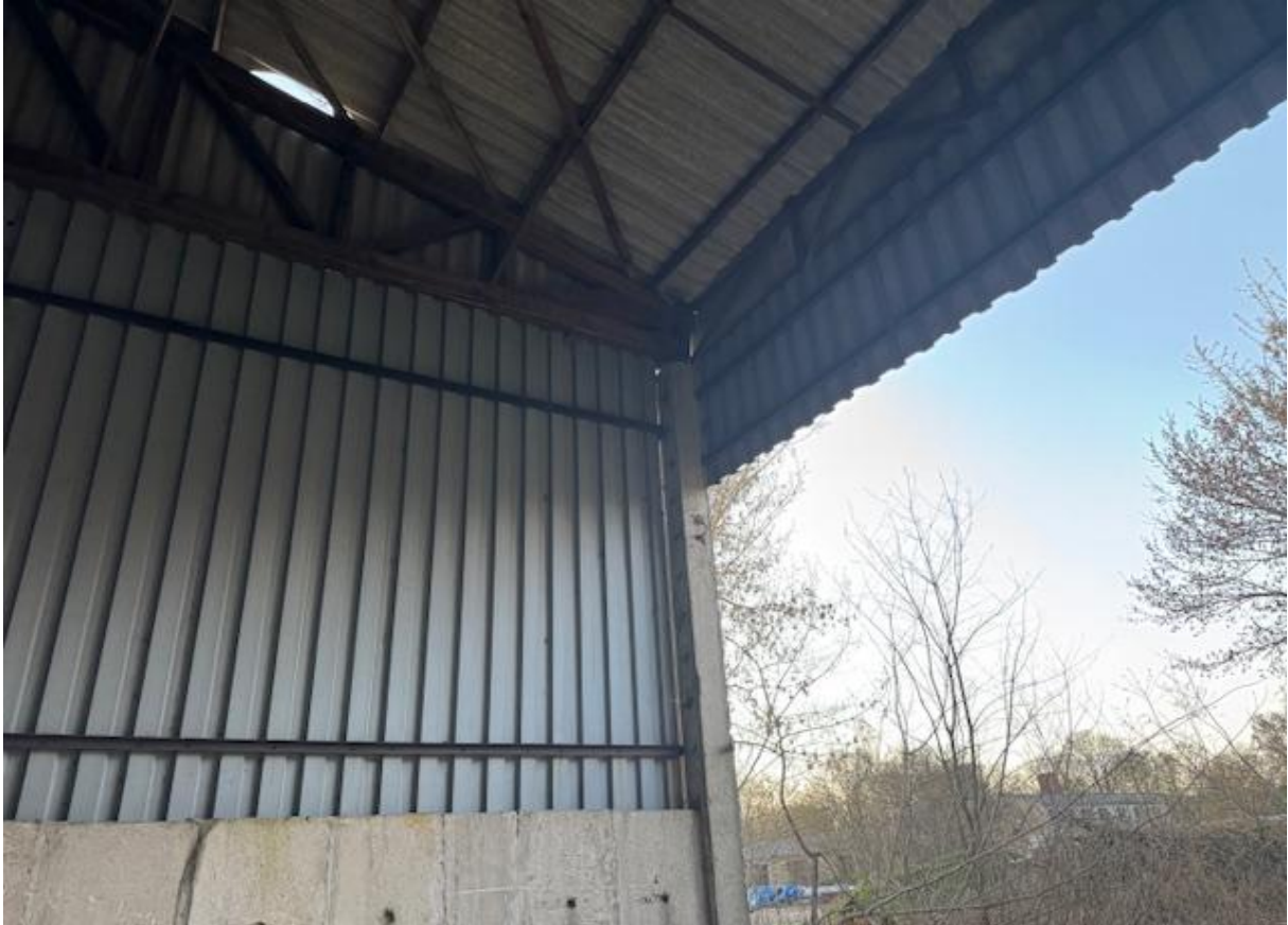
Halle H 1 Innenansicht; Blickrichtung Westen
