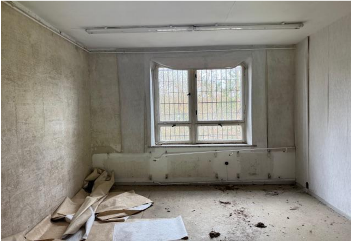
Innenansicht Gebäude VW
