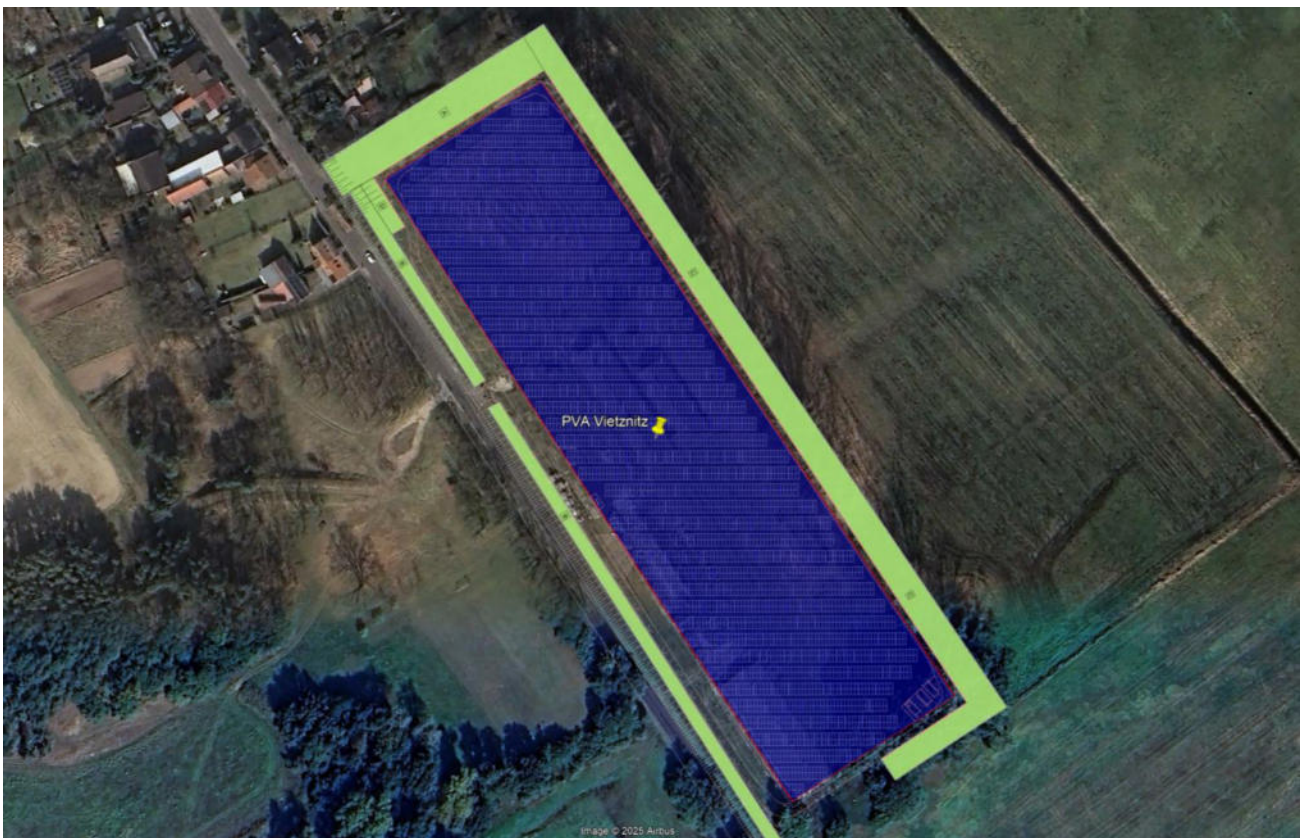
Bild 2.1.1.3: Detailansicht der PV Fläche (Quelle: Google Earth/SolPEG)
