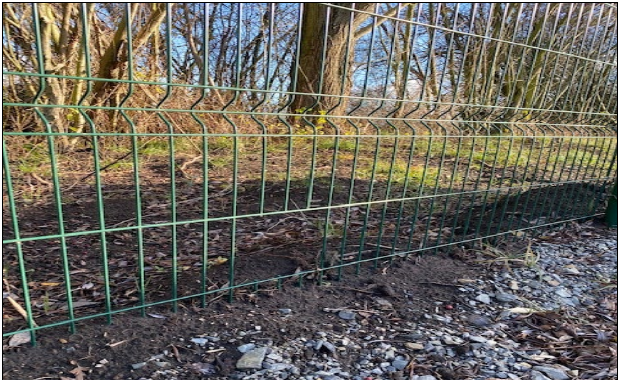
Abbildung 7: Einfriedung mit Öffnungen, um Durchgängigkeit für Kleintiere zu gewährleisten
