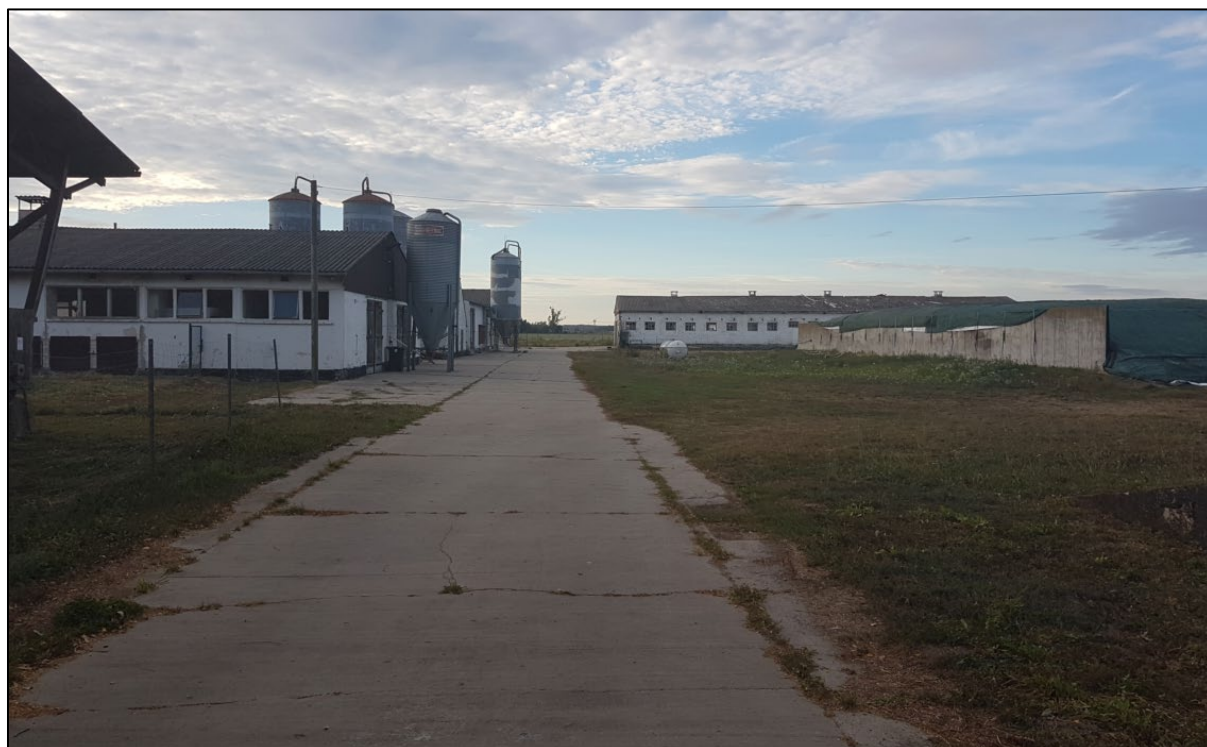
Abbildung 3: Blick auf die bestandsgeschützte Tierhaltungsanlage östlich von Gottesgabe
