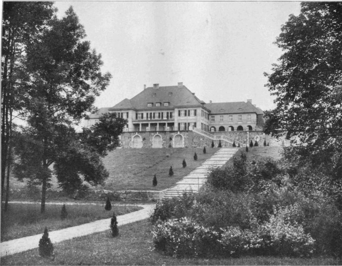
Abb. 77: Stützmauer und Rasenböschung von Südwesten, um 1912 (DBZ 48.1914 H.1 S. 44)
