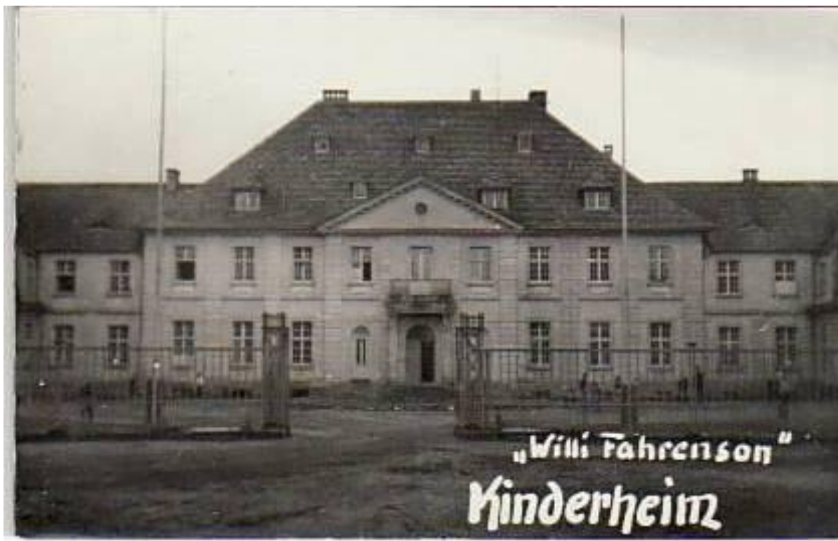
Abb. 137: Gutshaus und Hofanlage während der Zeit der Kinderheimnutzung, um 1970 (Postkarte)
