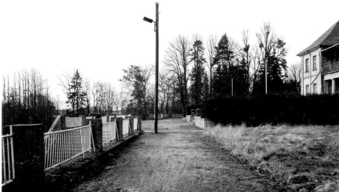
Abb. 180: Weg entlang der Stützmauer mit Mastleuchte, 1992 (Gutachten 1992, Foto 92)
