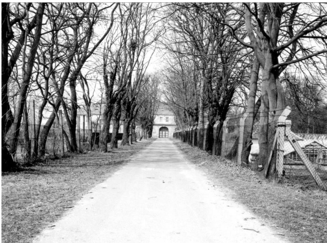
Abb. 171: Robinienallee mit beidseitiger Einzäunung, 1992 (Gutachten 1992, Foto 1)
