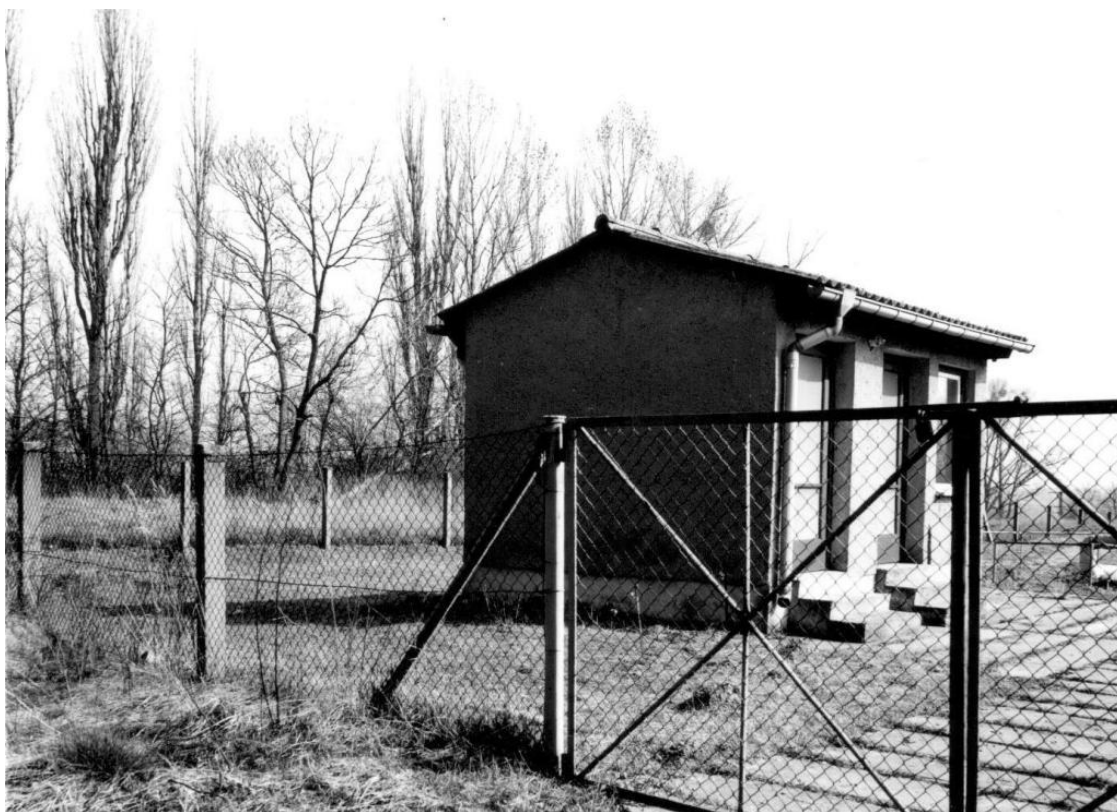
Abb. 174: Gebäude für die Steuerung der Entwässerungsanlage, 1992 (Gutachten 1992, Foto 15)
