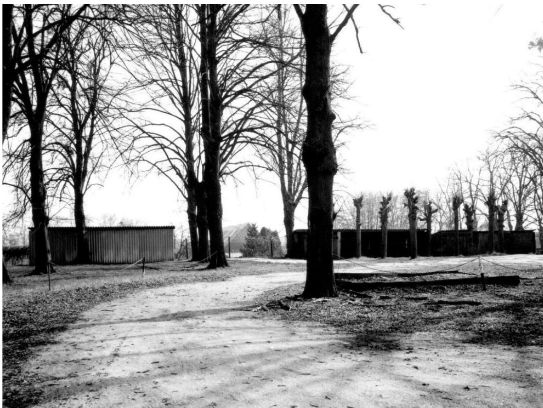
Abb. 173: Garage und Schuppen zwischen Vorfahrt und Gärtnergelände, 1992 (Gutachten 1992, Foto 8)
