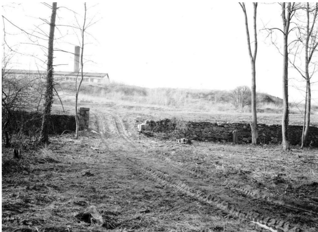
Abb. 194: Der Zugang von Nordwesten diente als Baustellenzufahrt, 1992 (Gutachten 1992, Foto 58)
