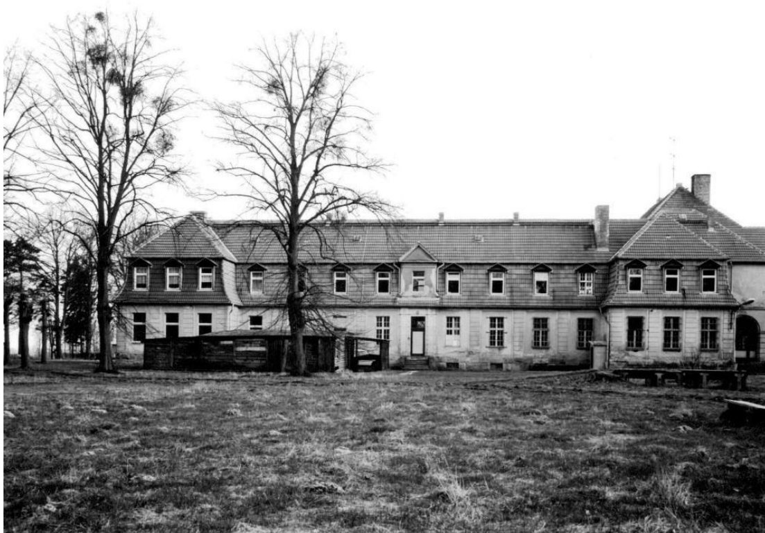
Abb. 175: Schuppen und Einbauten auf dem Areal vor dem Nordflügel, 1992 (Gutachten 1992, Foto 3)
