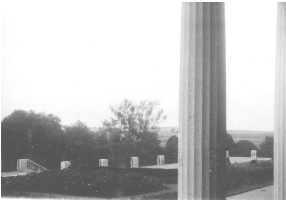
Abb. 73: Blick aus der Loggia nach Westen, um 1920 (Archiv S-H)
