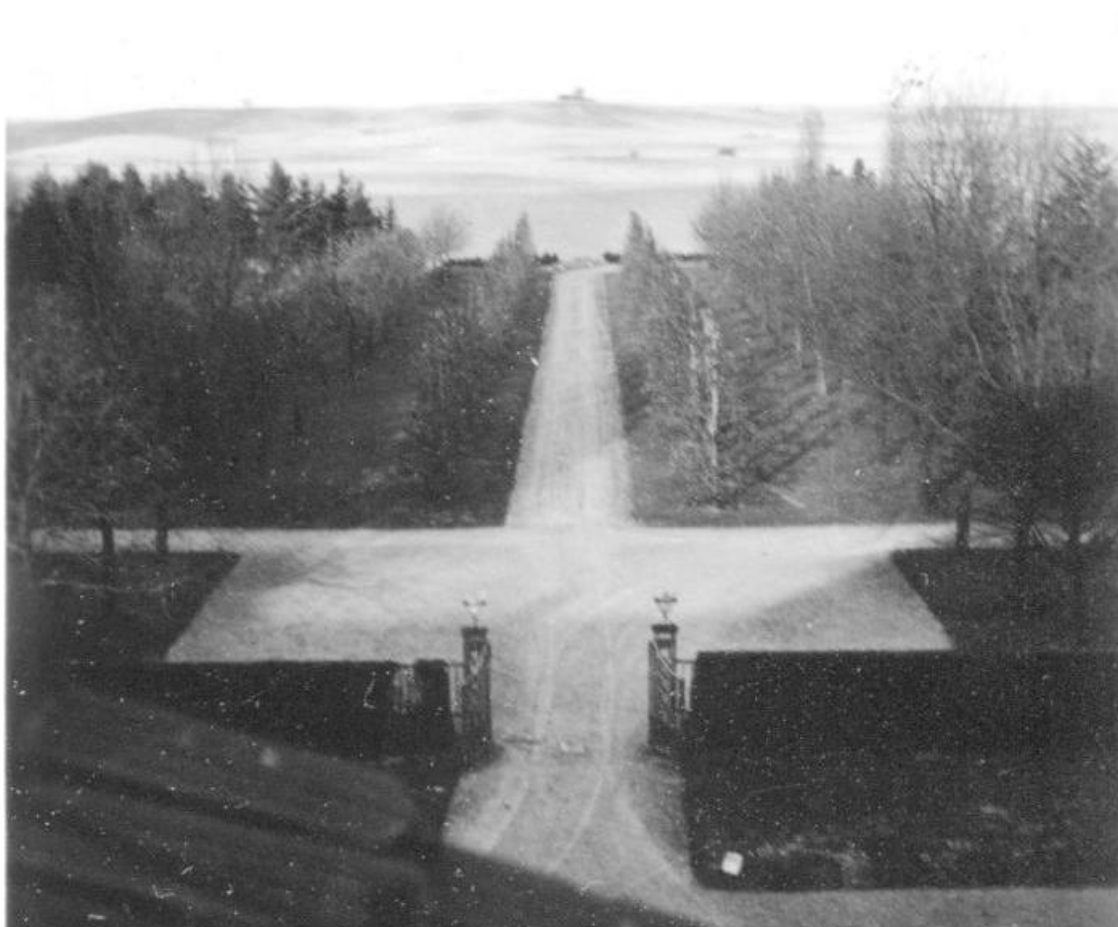
Abb. 54: Zufahrtsallee vom Dach des Gutshauses gesehen, um 1930 (Archiv S-H)
