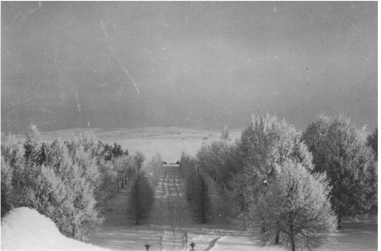
Abb. 55: Zufahrtsallee vom Dach des Gutshauses gesehen, um 1940 (Archiv S-H)
