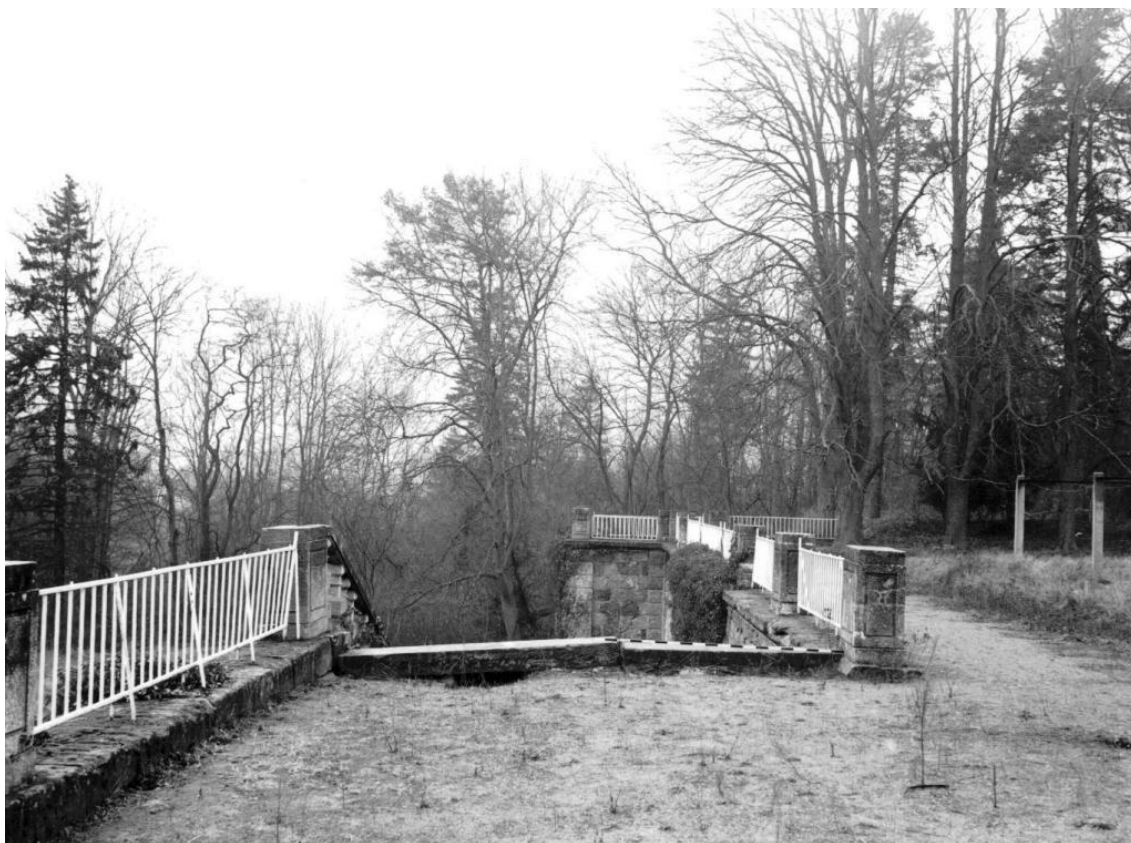
Abb. 181: Antritt des nördlichen Treppenabgangs, die Wegefläche liegt deutlich tiefer als die Stufe, 1992(Gutachten 1992, Foto 96)
