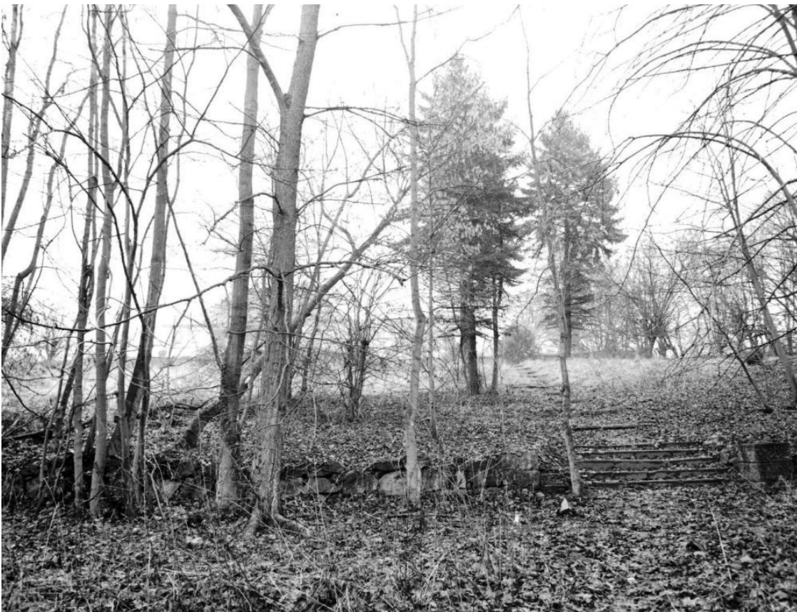
Abb. 178: Rechter Treppenweg und Baumaufwuchs vor der Stützmauer am Böschungsfuß, 1992 (Gutachten 1992, Foto 102)
