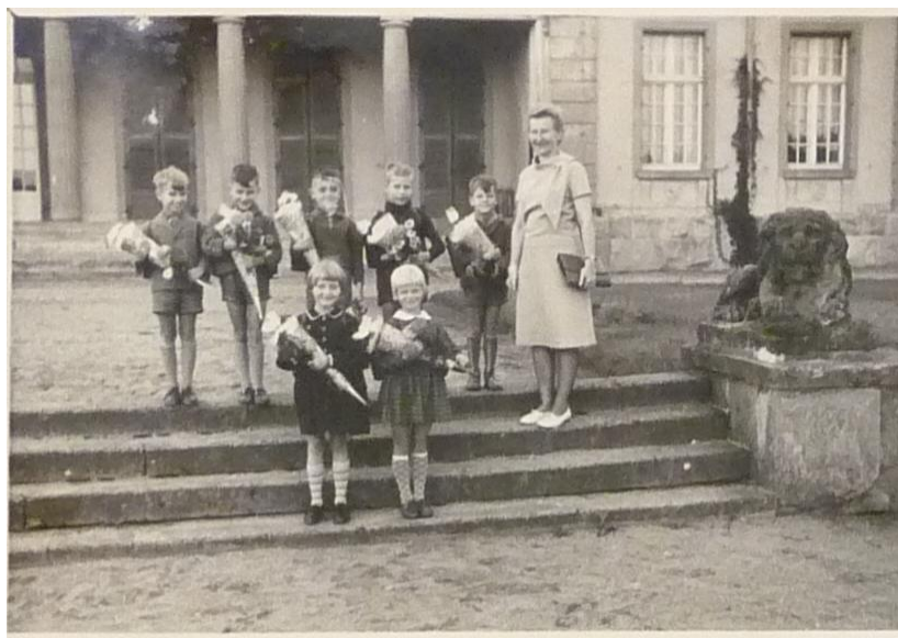
Abb. 140: Oben Treppe an der Loggia, Mitte und unten Gartentreppe, um 1970 (Kreisarchiv Prenzlau)
