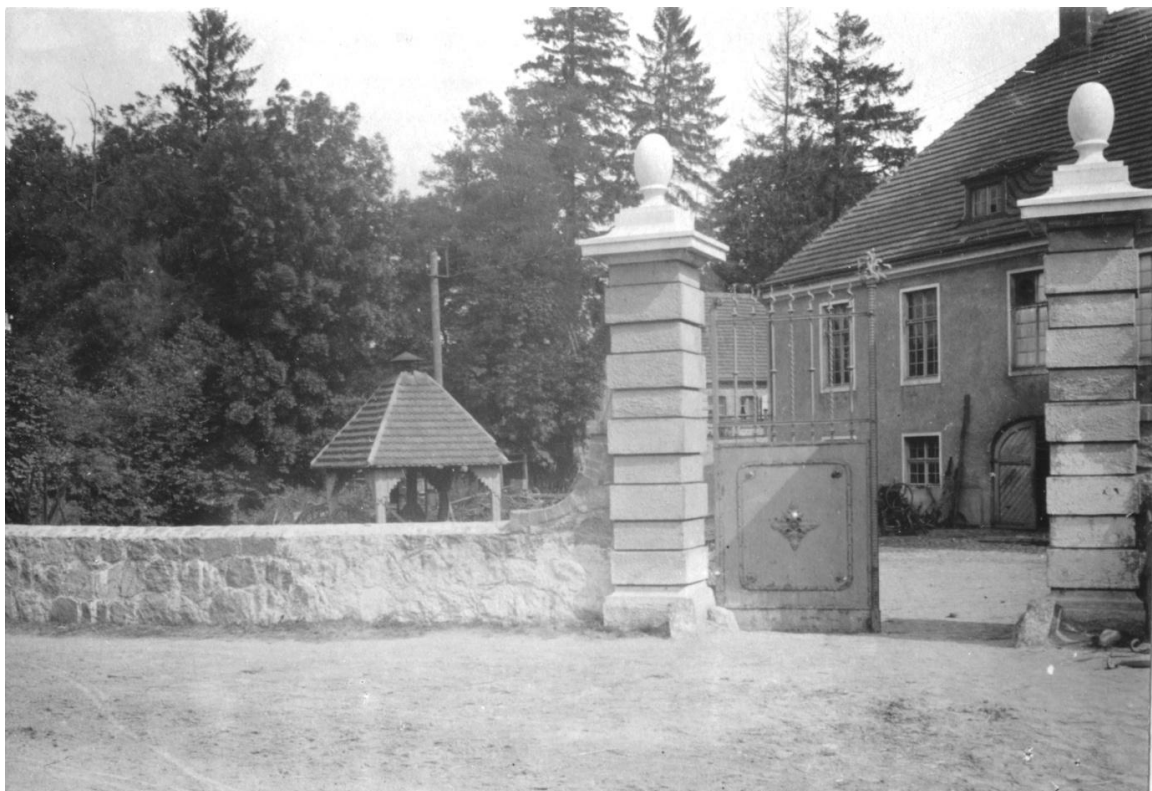
Abb. 122: Zugangstor zum Gutshof, um 1920 (Archiv S-H)
