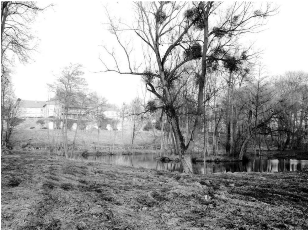
Abb. 190: Das Gelände am Nordufer des ersten Teichs ist nach der Entschlammung durch Baufahrzeuge beschädigt, 1992 (Gutachten 1992, Foto 72)
