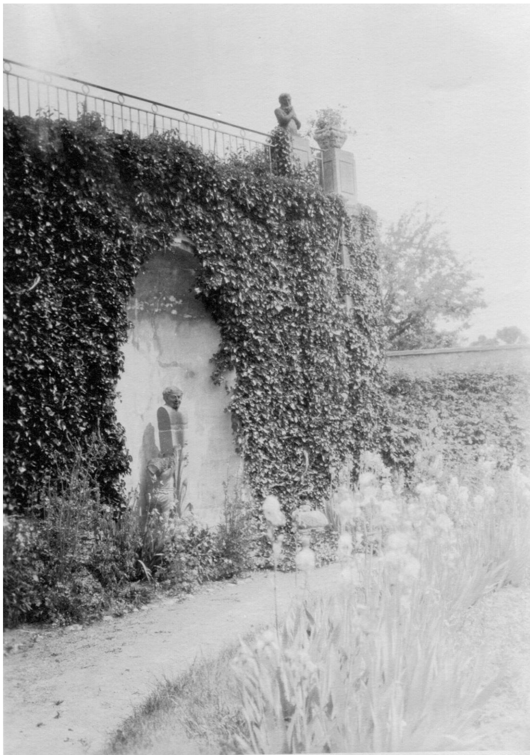
Abb. 107: Stützmauer am Rosengarten, um 1935 (Archiv S-H)
