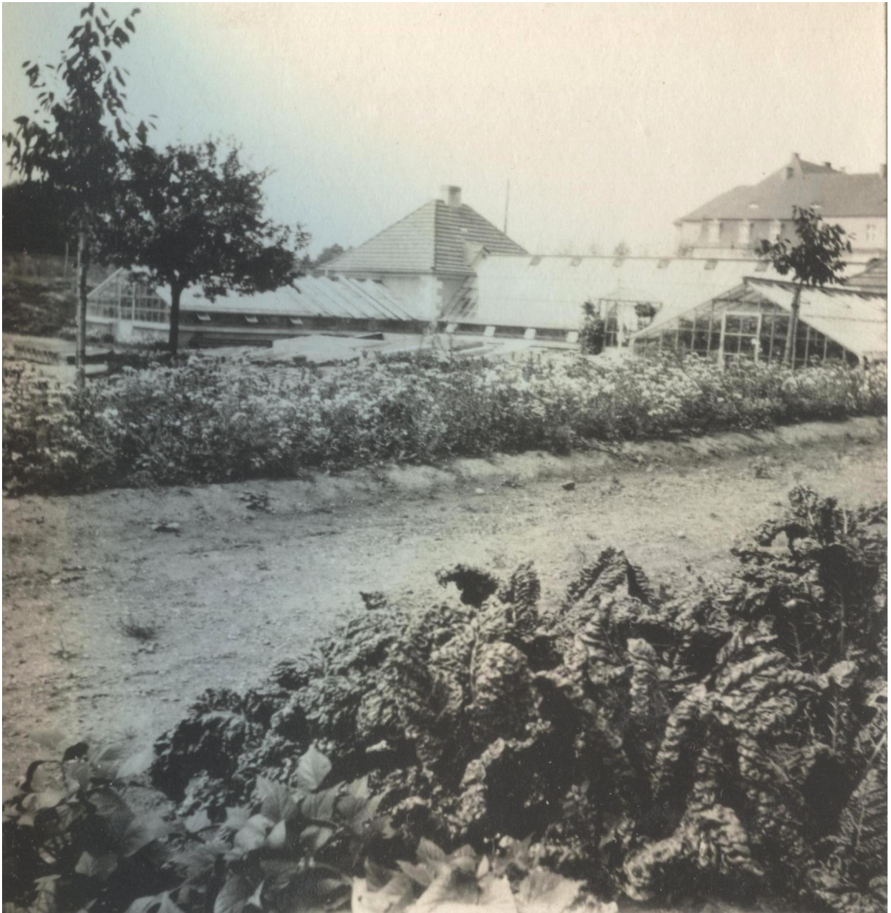
Abb. 118: Das Gewächshaus auf dem Gärtnerigelände von Nordosten, um 1920 (Archiv S-H)
