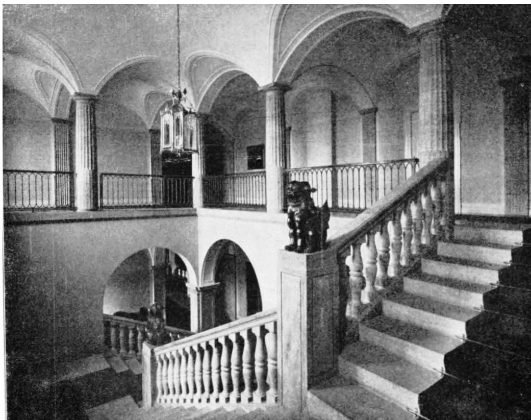
Abb. 130: Die Haupttreppe vom Obergeschoss aus gesehen, um 1912 (DBZ 48.1914 H. 1 S. 48)
