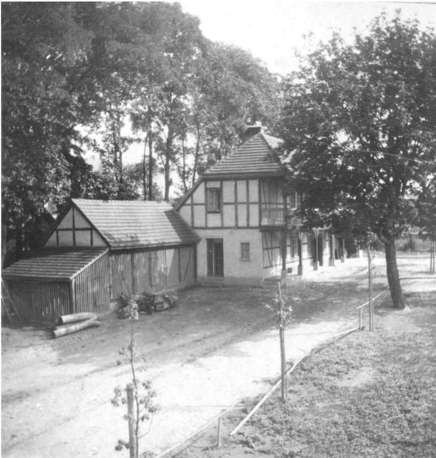
Abb. 123: Arbeiterhaus mit Schuppen im Gutshof, um 1920 (Archiv S-H)
