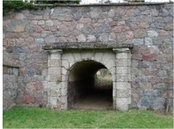
Abbildung 48: Feldsteinmauer mit Tunnel
