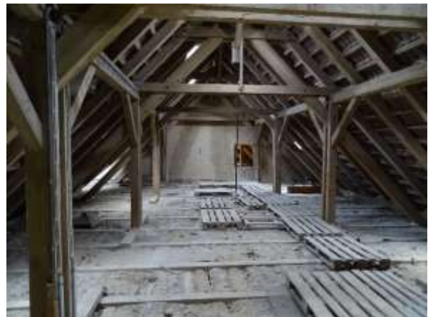
Abbildung 44: Dachstuhl mit Nachweis von Quartieren
