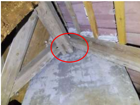
Abbildung 43: Hangplatz hinter der Dachkonstruktion
