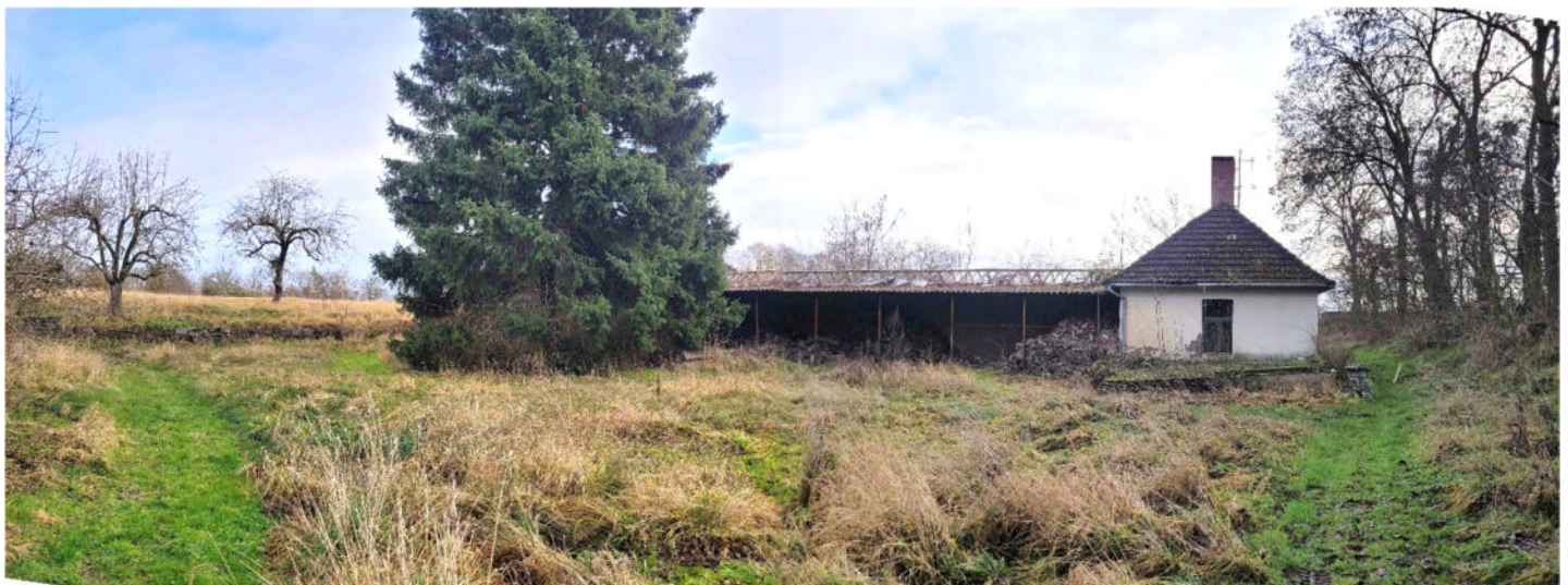
Abb. 5.: Blick auf den südlichen Bereich, rechts neben dem Bestandsgebäude Bohrstandort B 11, Situation 10. Dezember 2025
