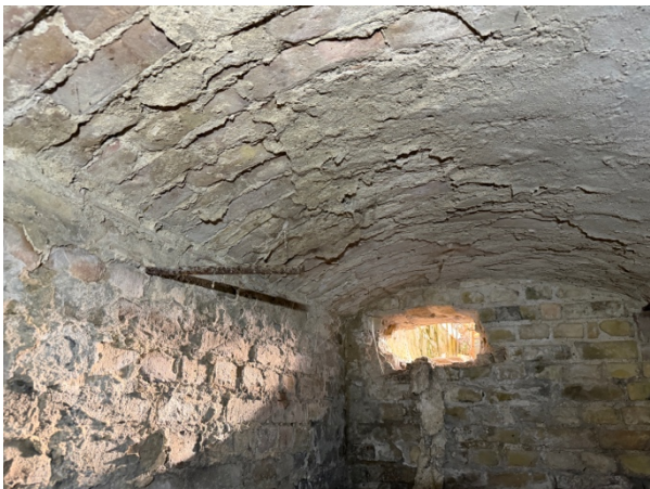
Abb. 12: Nicht mehr genutzter Gewölbekeller
