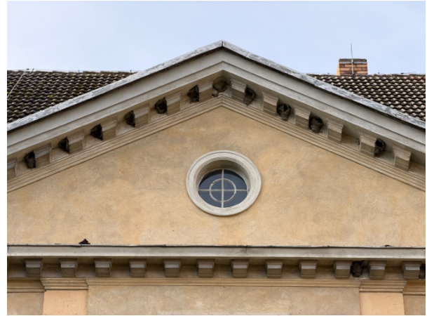
Abb. 5: Mehlschwalben im Giebel über dem Haupteingang
