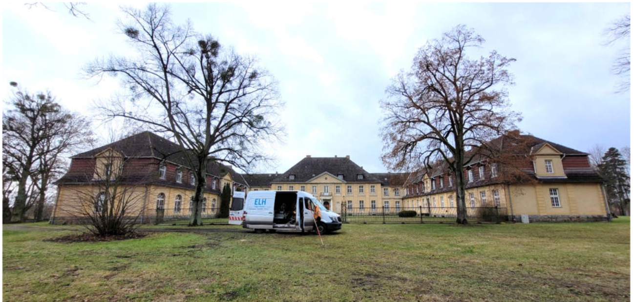
Abb. 3.: Blick auf das Gutshaus von Osten, Bohrstandort B 5, Situation 10. Dezember 2025
