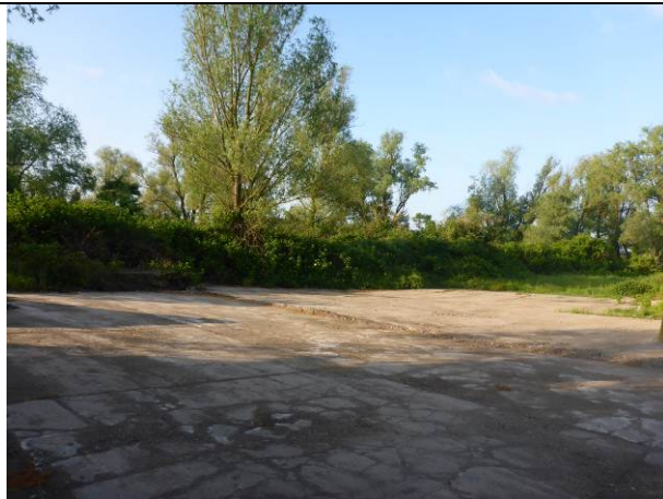
Abbildung 14: Flächen um die ehemaligen Stall- und Lagergebäude mit Beton befestigt
