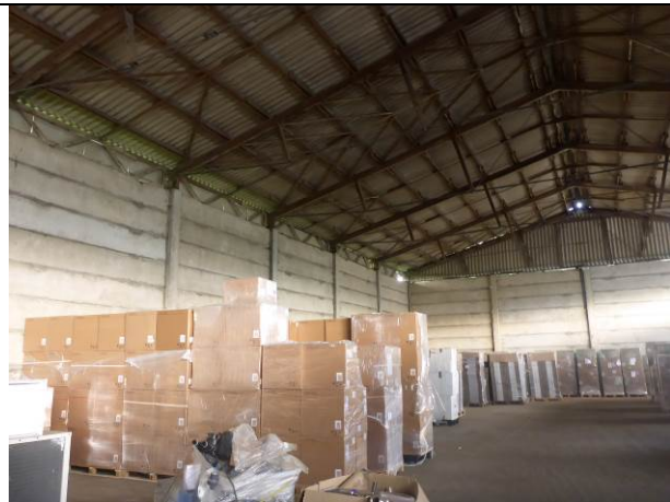
Abbildung 32: südl. Halle, Asbesteindeckung, keine Habitatstrukturen
