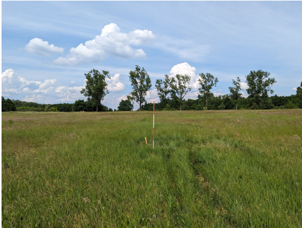
03. Ansicht Kleinrammbohrung BS 05/24
