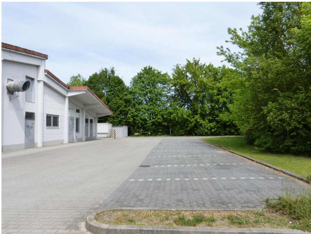
Bild 10: Zufahrt und Parkplätze auf der Ostseite des REWE-Markts
