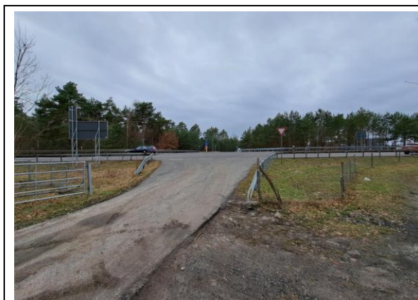
Abbildung 34: Blick auf die B 168 vom Untersuchungsgebiet
