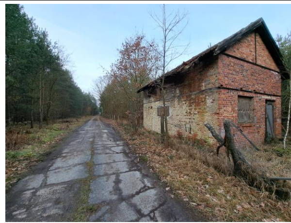
Abbildung 54: Altes Backsteingebäude am Waldweg
