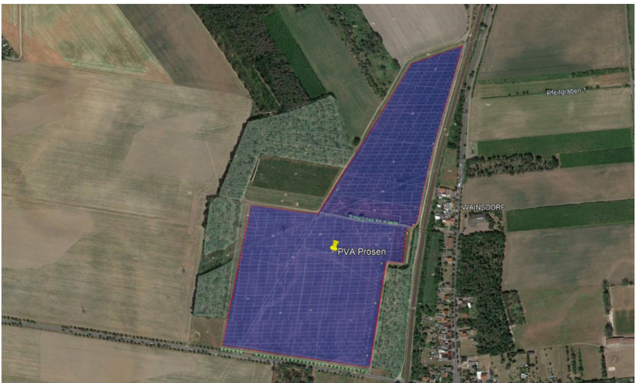
Bild 2.1.3: Detailansicht der PV Fläche (Quelle: Google Earth/SolPEG)
