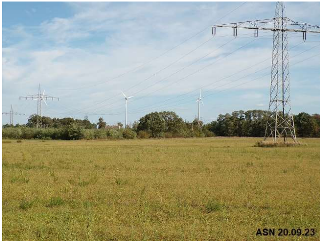
Foto 1: Acker mit Überspannung durch die 110-kV-Freileitung, im Hintergrund Windpark Wainsdorf
