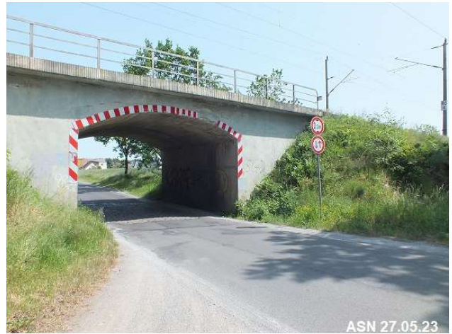
Foto 8: Straßenunterführung unter der Bahnstrecke im Südosten des UG
