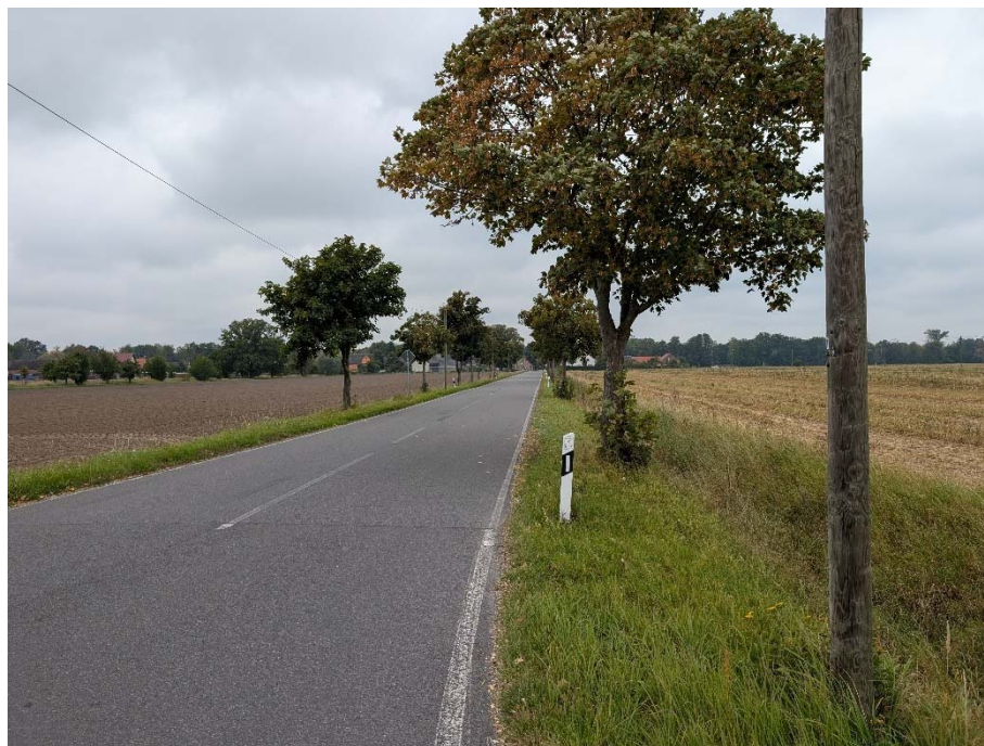
Kreisstraße K 6137 mit Allee aus Kastanien und Berg-Ahornen im Südwesten des UG
