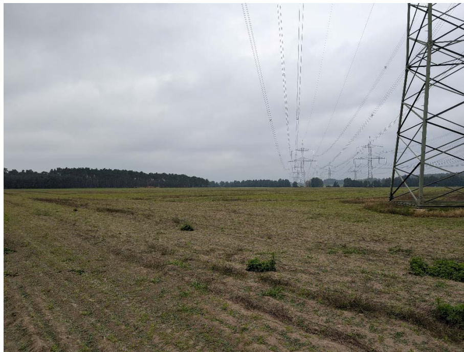
Intensivacker mit querender 380-kV- Freileitung bei Kreblitz
