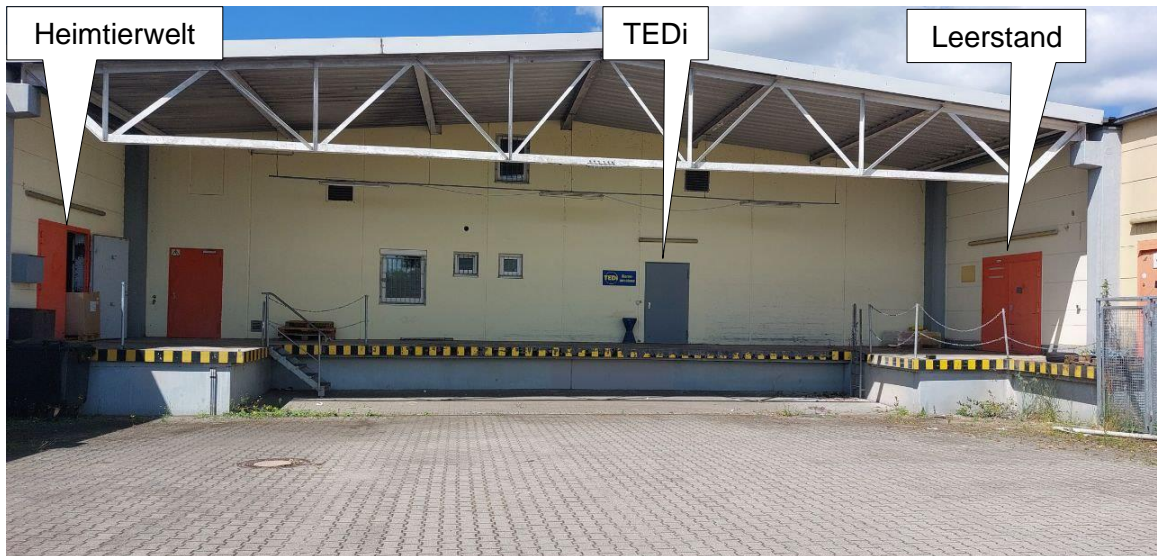
Abbildung 8: Rückwärtige Anlieferung des NVZ, eigenes Foto, Blick nach Westen (28.06.2023)
