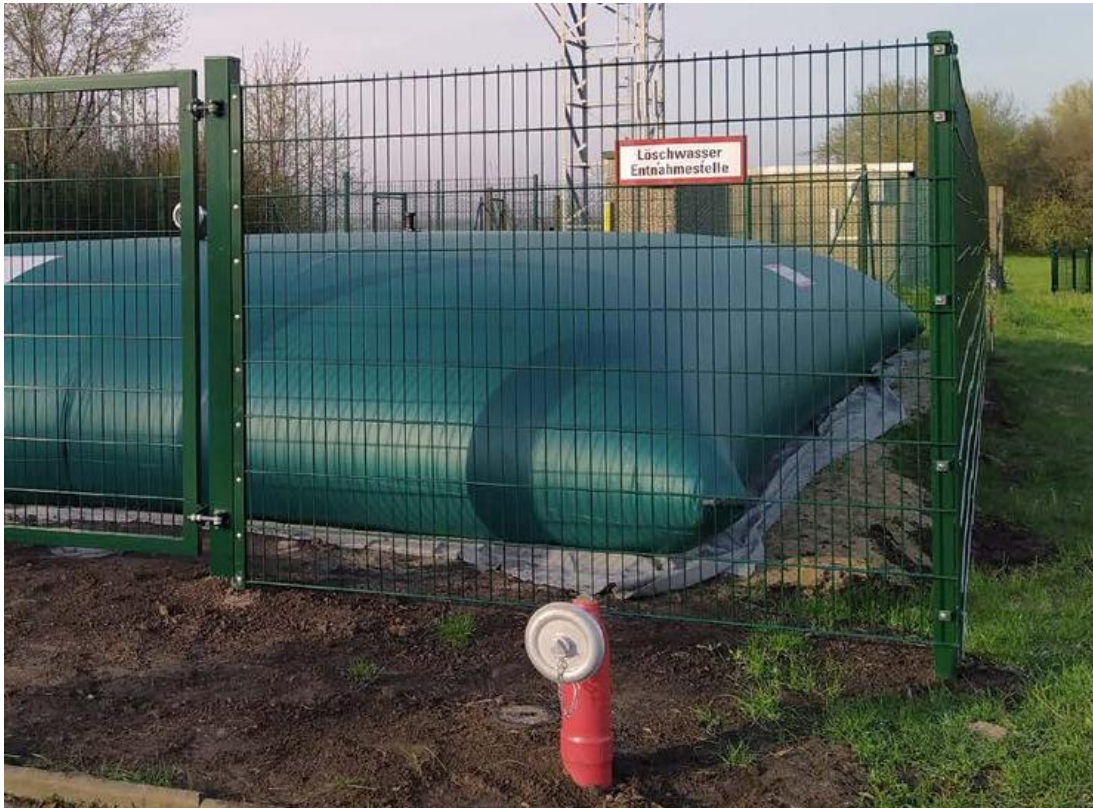
Abbildung 5: Löschwasserkissen und Hydrant
