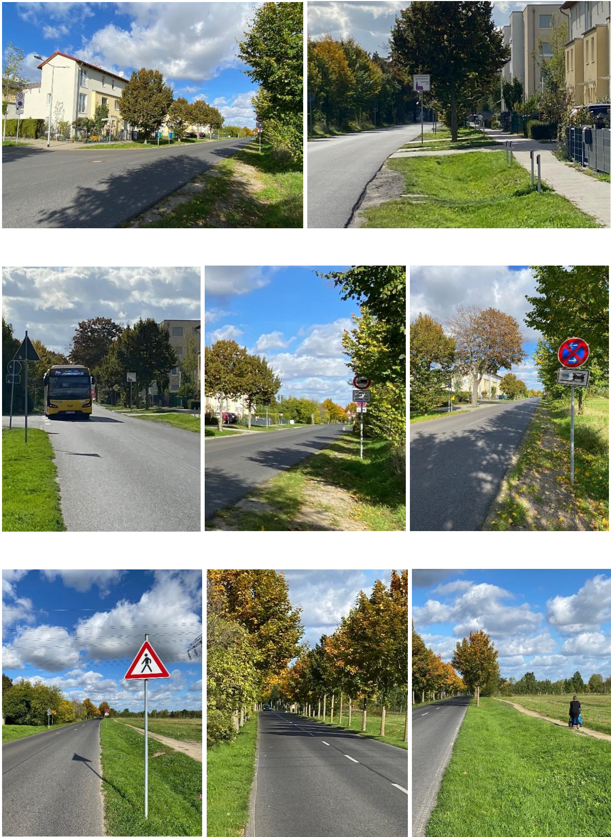
Abbildung 4 Bestandsdokumentation Rudower Chaussee
