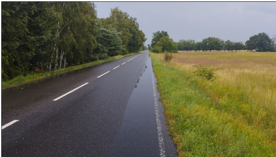
Straße vom Gewerbegebiet Luckau kommend im Süden des Planungsraums mit Kiefern-/Birkenforst (08686) auf der linken und Ackerbrache (09140) auf der rechten Seite
