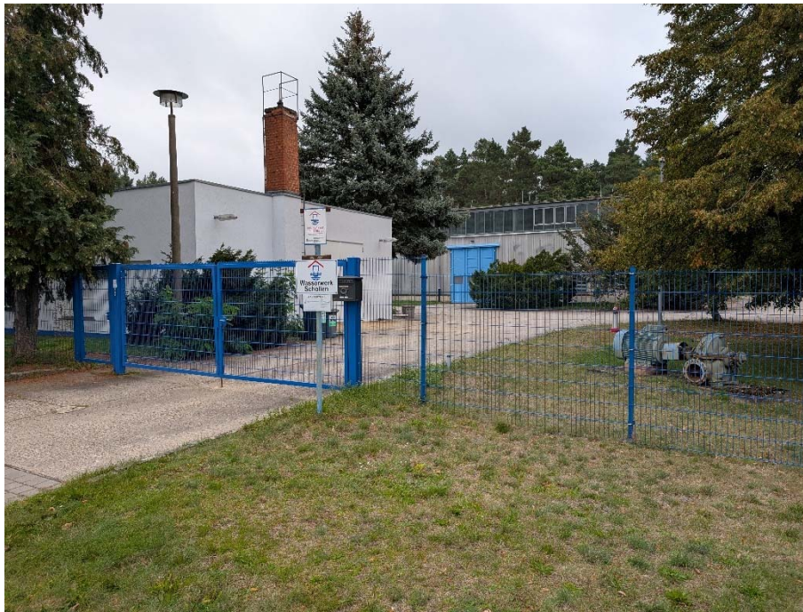
Wasserwerk Schollen mit hohem Grünflächen- und Gehölzanteil
