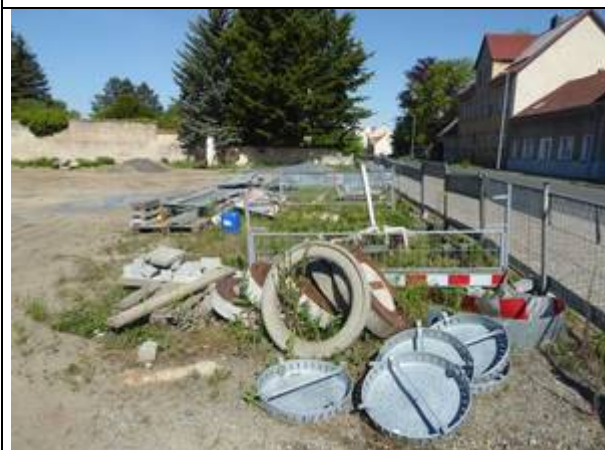
Foto 5: Lagerfläche von Baumaterialien (Foto: Wiesner, 12.5.25)
