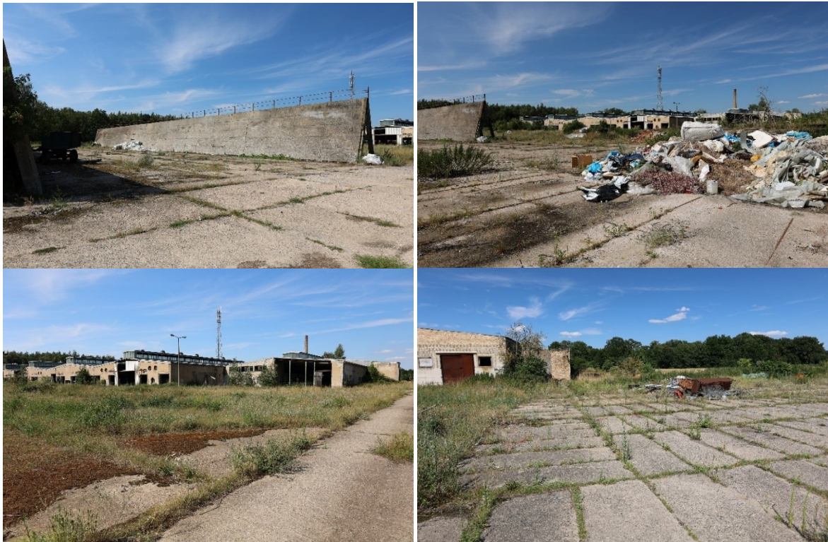
Abbildungen 13: Aktuelle Ausprägung der Rückbauobjekte und Flächenentsiegelungen bei der Ortslage Paulinenaue; Aufnahme: H. Roßmann 07/2024
