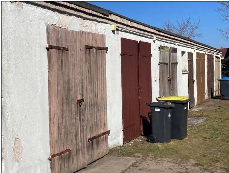
Abbildung 7: Ausprägung der Garagen mit eingeschätzten Potenzialen für Fledermäuse; Aufnahme: Hagen Roßmann 03/2025
