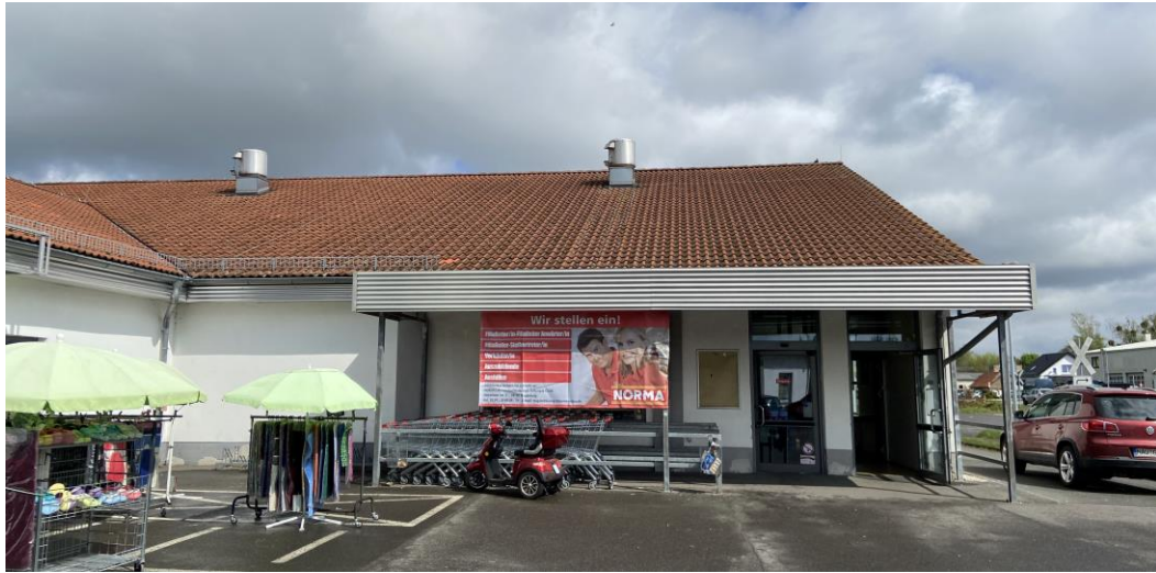
Abbildung 20: Norma-Lebensmitteldiscounter am Sonderstandort Berliner Straße/Raiffeisenstraße in Nauen
