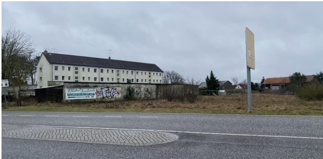
Abbildung 2: Blick auf den Vorhabenstandort von der B5
