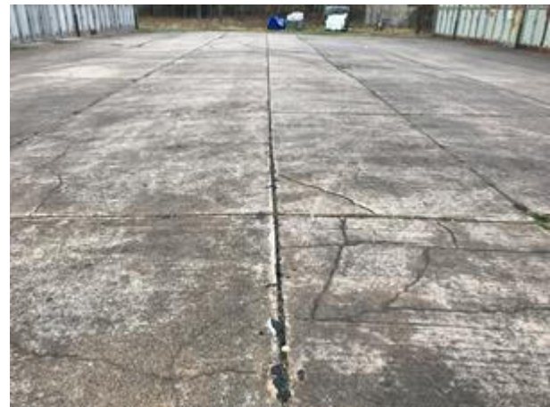
14: Betonplatten mit Fugen zwischen Halle 5+18
