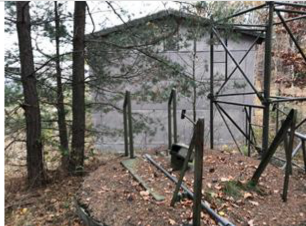
30: Gebäude P mit Schacht
