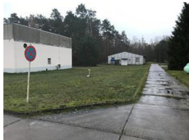
10: Blick auf Unterkunftsgebäude I
