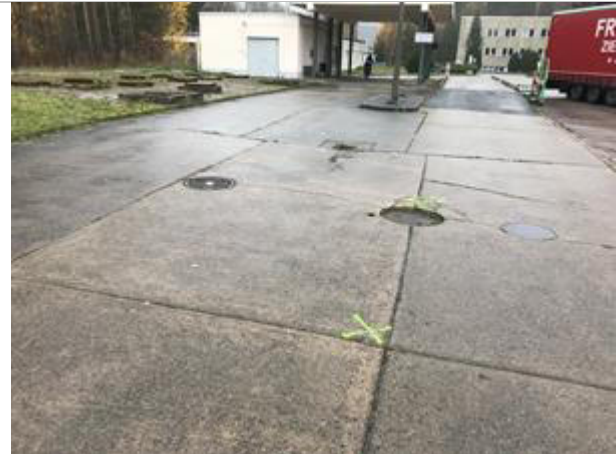
12: Schachtdeckel vor Tankstelle
