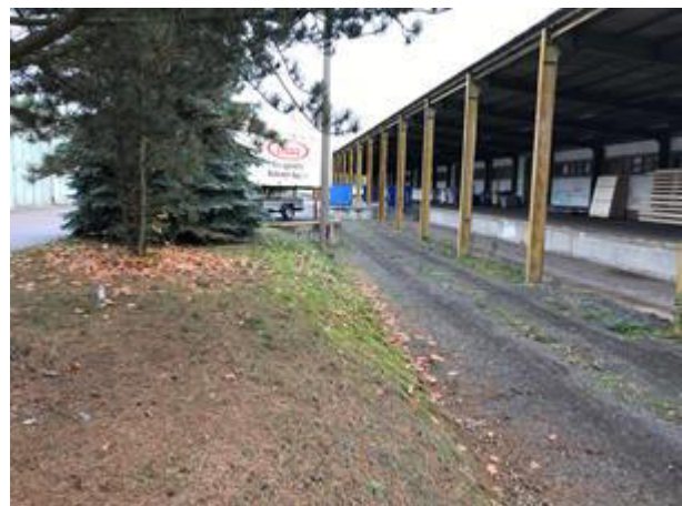
34: Ehemaliger Bahnsteig an Halle 13
