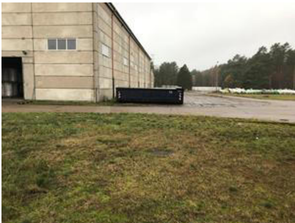
13: Blick auf Nordseite von Halle 13
