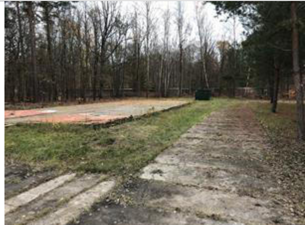
24: Bodenplatte ehemaliges Gebäude H
