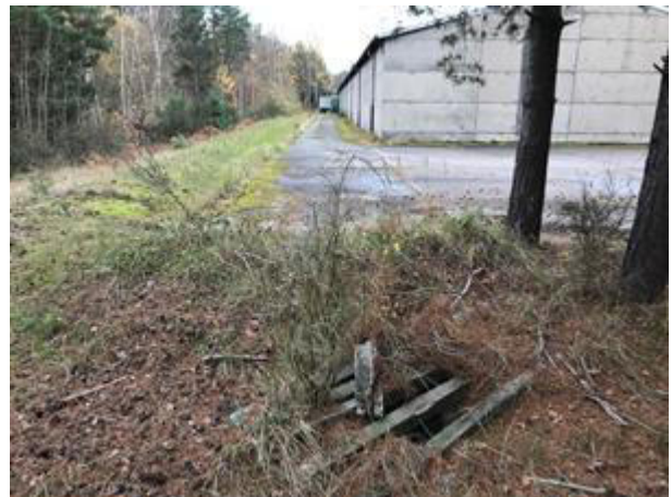
20: Halle 1/4 mit Schacht
