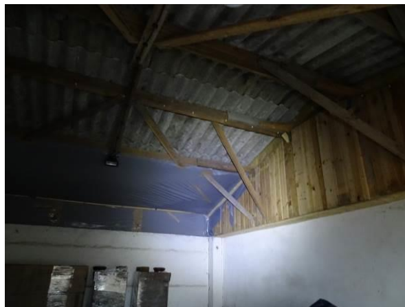
Abbildung 46: ungedämmtes Dach des ehemaligen Munitionslagers
