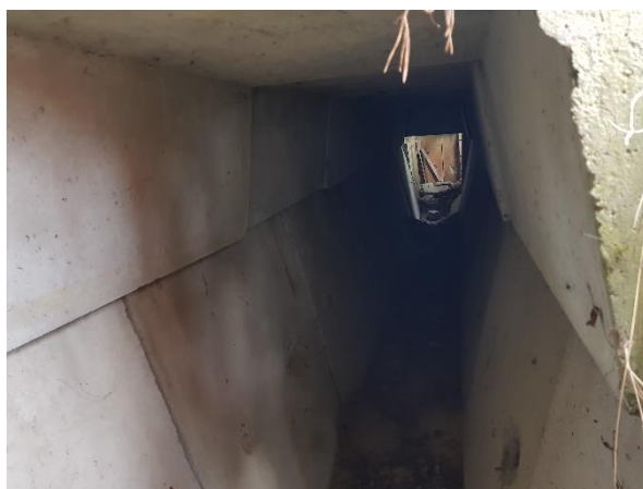
Abbildung 72: Bunkerrest von innen
