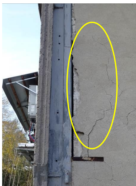
Abbildung 54: Spalt und Putzblase (gelber Bereich) an südöstlicher Ecke
