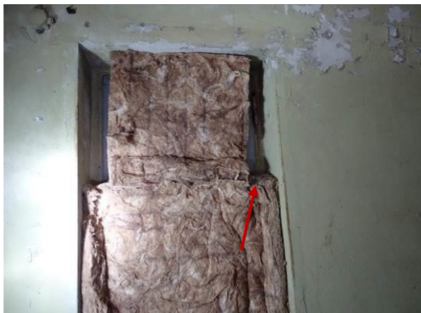
Abbildung 67: Nische im Anbau mit Dämmung und Nest (roter Pfeil)
