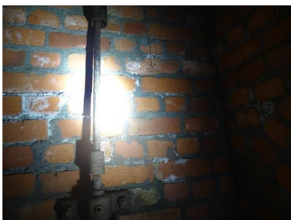
Abbildung 77: gemauerte Wand in einer der Nischen im Rohr
