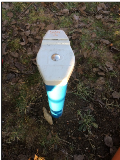
Foto 3: Modifizierter Messstellenkopf (Edelstahl-Flach-Rundkopf-Schraube)
