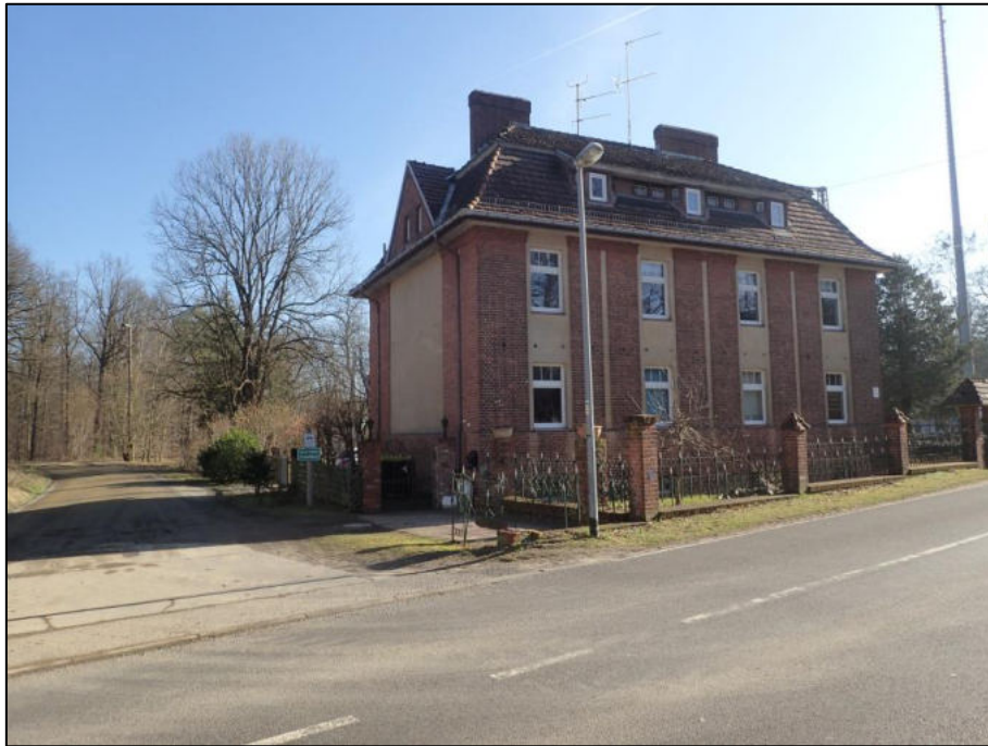
Abbildung 33. Blick von Straße der Befreiung (Bahnhofstraße) in Richtung Südosten auf die West- und Nordfassade des Gebäudes Bahnhofstraße 12.
