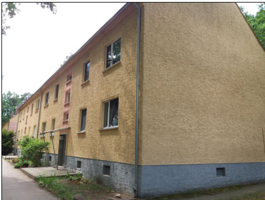
Abbildung 27. Blick in Richtung Südwesten auf die Nord- sowie Ostfassade des Gebäudes Straße der Befreiung 8 und 9.
