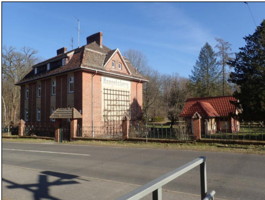
Abbildung 34. Blick von Bahnhofstraße in Richtung Nordosten auf die West- und Südfassade des Gebäudes Bahnhofstraße 12.
