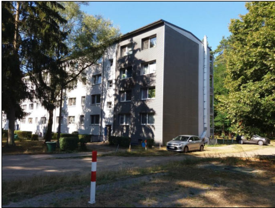
Abbildung 21. Blick in Richtung Südwesten auf die Nord- sowie Ostfassade des Gebäudes Straße der Befreiung 2 bis 7.
