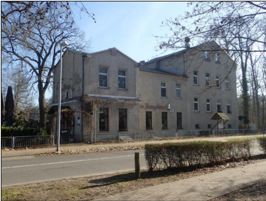
Abbildung 35. Blick von Bahnhofstraße in Richtung Südosten auf die West- und Nordfassade des Gebäudes Bahnhofstraße 7.
