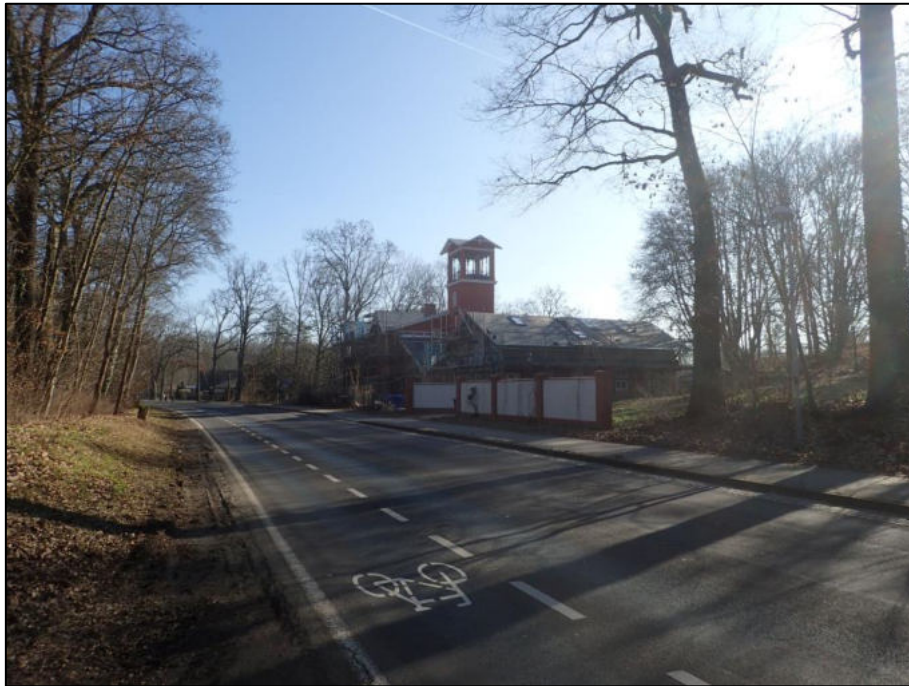
Abbildung 68. Blick von Berliner Damm in Richtung Süden auf 2 Gebäude ohne erkennbare Hausnummern, vorliegend als Berliner Damm 7 bezeichnet.
