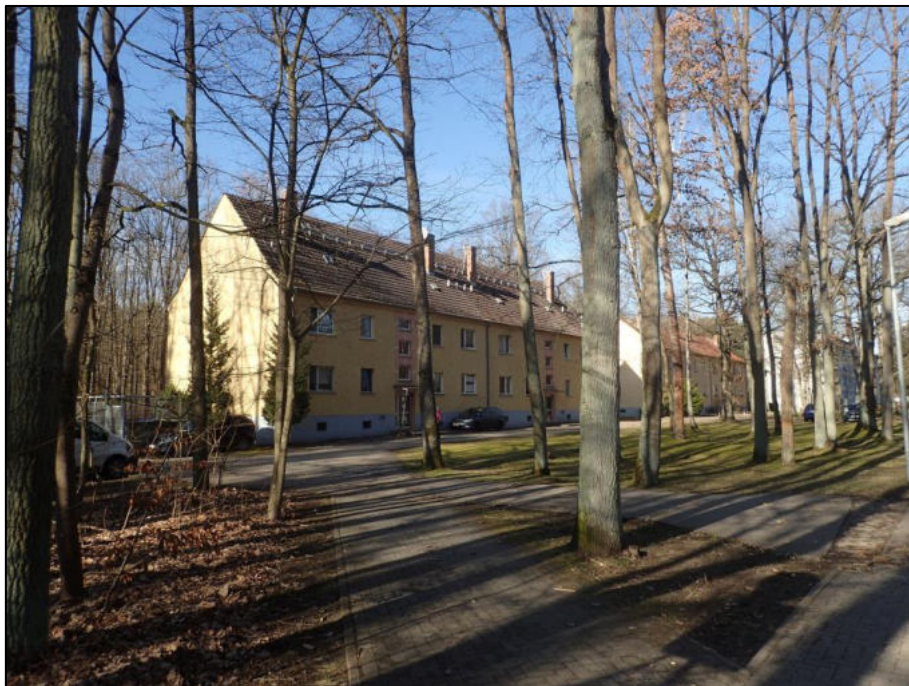
Abbildung 25. Blick von Straße der Befreiung in Richtung Nordwesten auf die Süd- und Ostfassade des Gebäudes Straße der Befreiung 10 und 11. Im Hintergrund das baugleiche Gebäude Nr. 8 und 9.
