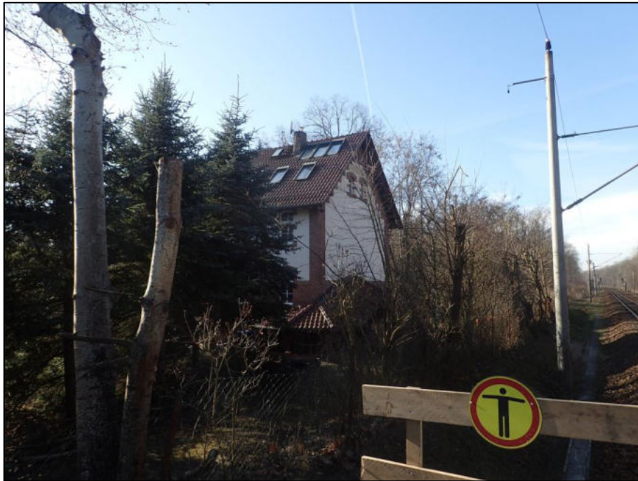
Abbildung 32. Blick vom südlichen Bahnsteig des Bahnhofs Hangelsberg in Richtung Südwesten auf Nord- und Ostfassade des Gebäudes Bahnhofstraße 8.
