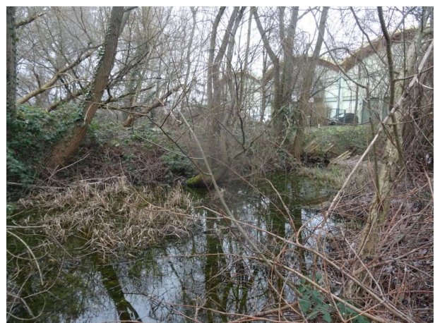
21.03.2023, , Regenrückhaltebecken mit stehendem Wasser
