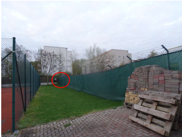
Aussparung der Grundstück umgebenden Einfriedung
