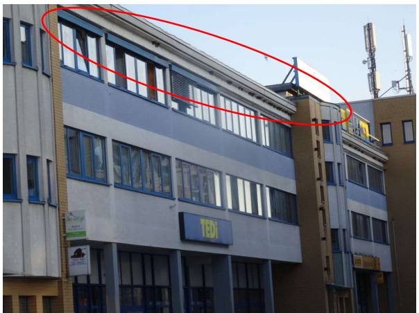
Weiterer teil-Standort der Mehlschwalbenkolonie am Gebäude des Forum Bernau
