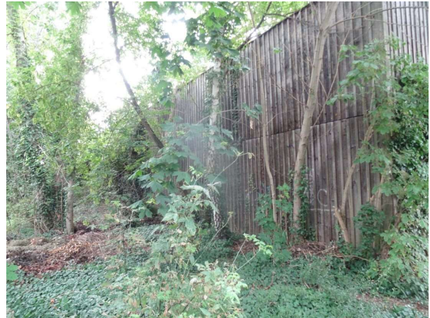
Holzzaun als südliche Umgrenzung des GB
