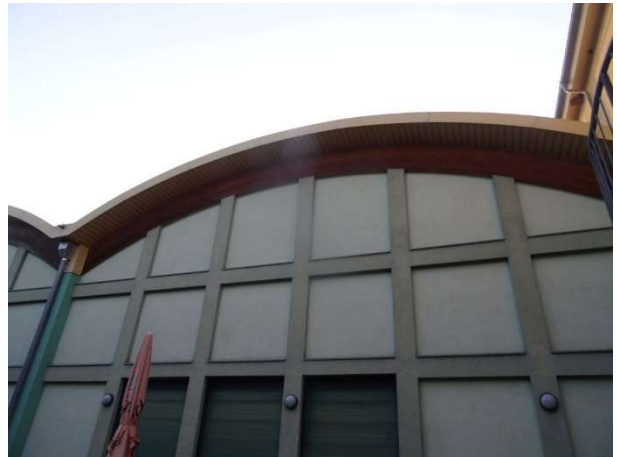
Holzverkleidung unter Dachkante, Quartierspotenzial
