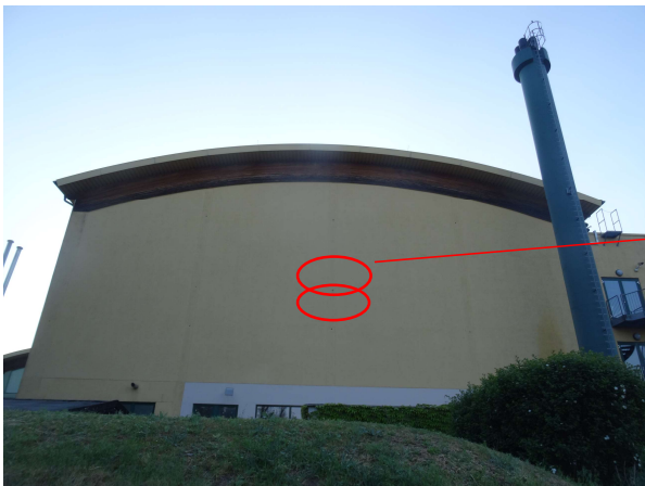
Fassade mit Niststätten von Star (oben) und Haussperling (unten)
