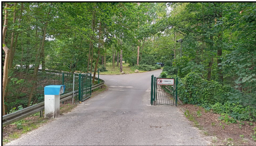
Einfahrt Wohnanlage Seeallee/ Parkallee (156 WE)
