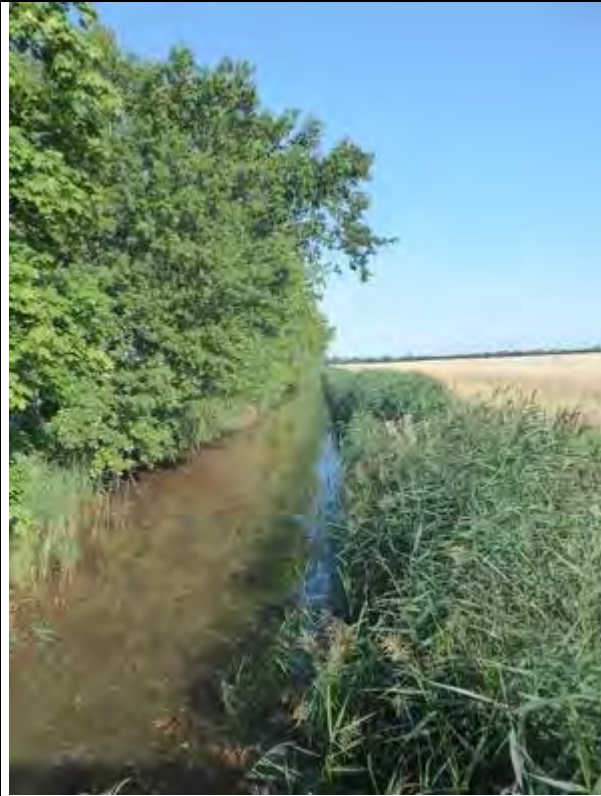
Foto 7: Großthiemig-Grödener Binnengraben am Südrand des Vorhabengebietes (Foto: Wiesner, 13.7.23)
