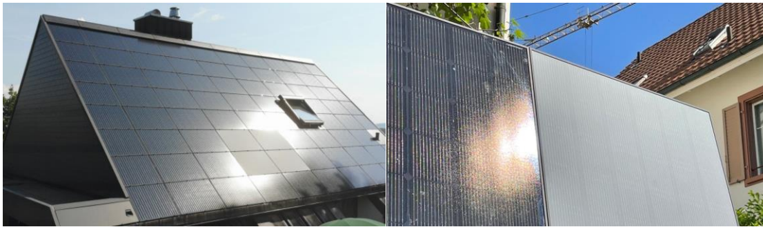
Abbildung 8: links: Module mit satinierter Folie [3], rechts: nachträglich sandgestrahltes Modul [4]
