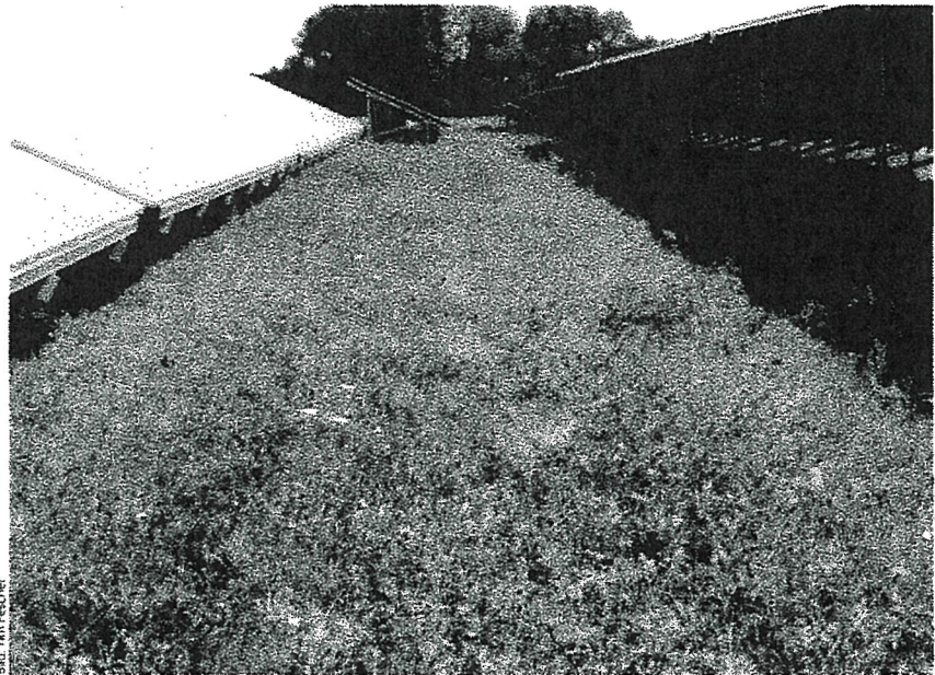
Abb. 7: Besonnter Streifen von mehr als 2,5 m Breite in einer Anlage bei Werneuchen um die Mittagszeit
